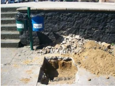
Imagen 6.81: Cala para verificar niveles de piso anteriores al existente.
