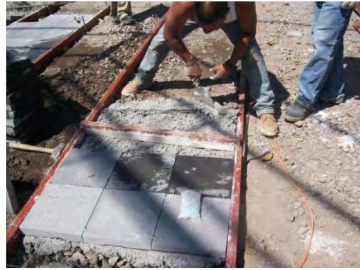
Imagen 2.38: Cimbra, mezcla y piezas de resinto.
