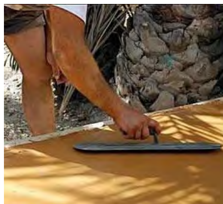
Imagen. 2.11: alisado del concreto.
