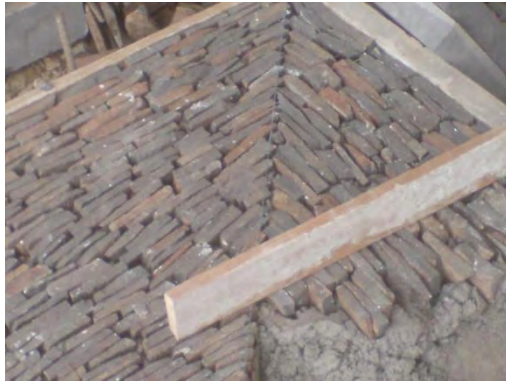
Imagen 2.43: Piedra laja nivelada y situada con mezcla cementante.
