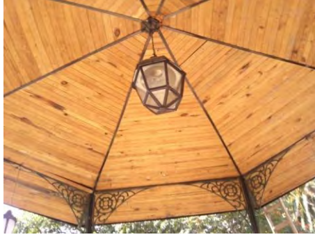
Imagen 6.87: Plafón de duela previo al deshabilitado de la estructura. plafón.
