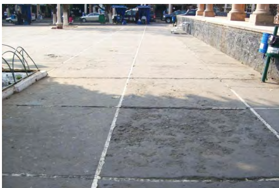
Imagen 4.61: Acercamiento a detalles de deterioro del piso, anterior a la modificación.
