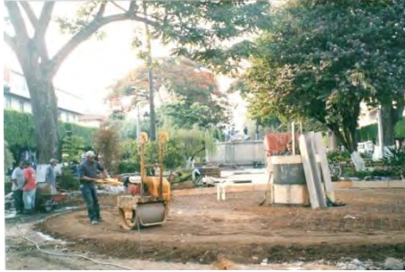
Imagen 6.101: Muestra el inicio de la construcción de la fuente en el año 2004.
