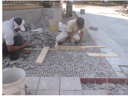
Imagen 2.44: Piedra laja esquinas de la zona perimetral al kiosco
