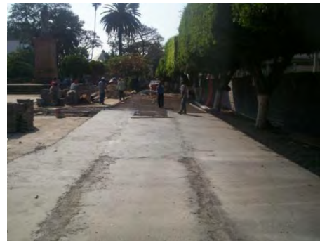
Imagen 6.100: colado de firme concreto ahogando malla electrosoldada.
