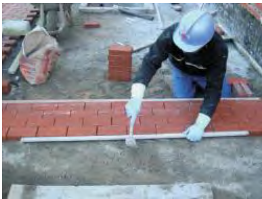
Imagen 2.24. Cuatrapeo de adoquines.
