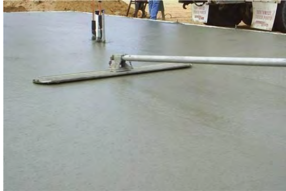
Imagen 2.7 superficie terminada de firme de concreto.
