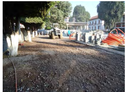
Imagen 2.32: Compactación del terreno para mejorar la superficie.
