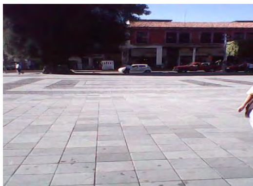
Imagen 4.60: De esta manera se le dio el acabado final a la fuente, quedando a ras de piso y la cual se denomina fuente seca.
