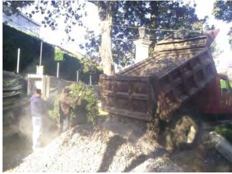
Imagen 6.93: Acamellonado de base hidráulica para mejorar superficie. finos.
