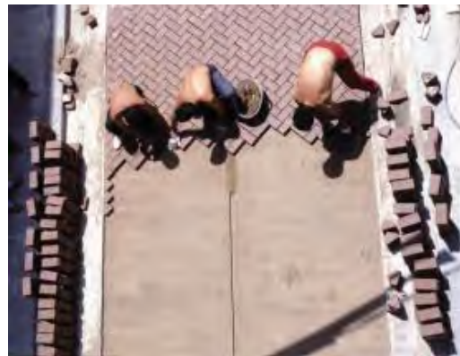
Imagen: 2.25: Colocación de adoquines forma escama de pescado.
