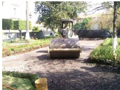
Imagen 6.96: Compactación al 100% de prueba AASHTO modificado.
