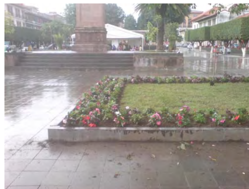
Imagen 4.52: El barandal fue sustituido por guarnición de piedra tipo resinto de 25 cm de peralte.
