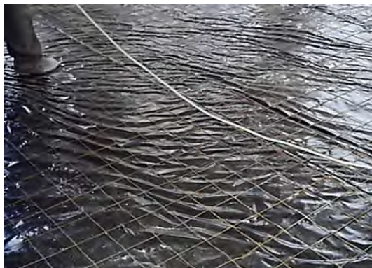
Imagen 2.4. Refuerzo de acero colocación de malla en la parte superior a 4 cm de la superficie.
