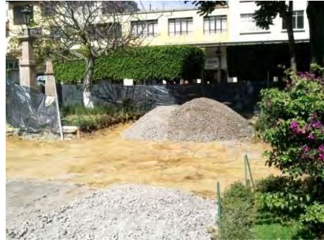
Imagen 6.94: Base hidráulica de material granular de ¼” de pulgada a finos.
