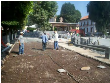
Imagen 6.99: Colocación de malla electrosoldada.
