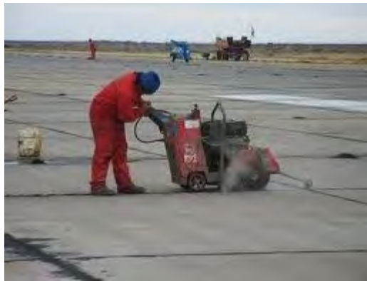
Imagen: 2.16 Juntas de contracción.
