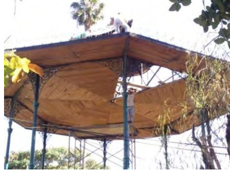
Imagen 6.88: Muestra el comienzo de deshabilitado de instalaciones y
