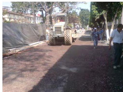
Imagen 2.34: nivelado y compactado de base..
