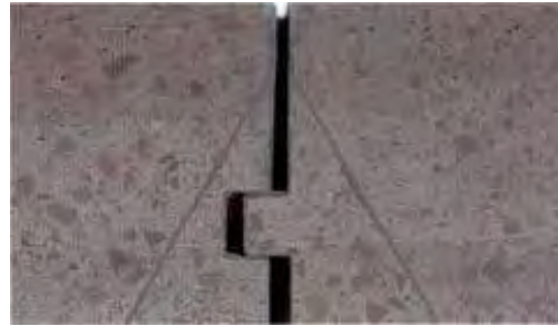
Imagen: 2.15 Juntas de dilatación
