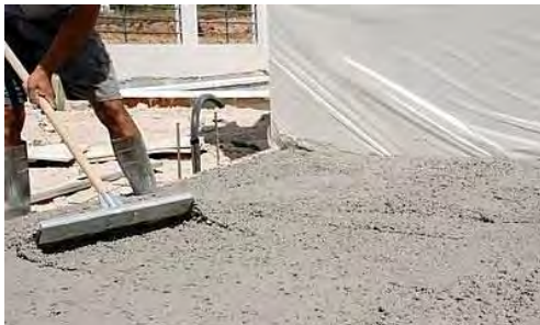
Imagen 2.1. Rastrillo para distribuir concreto.
