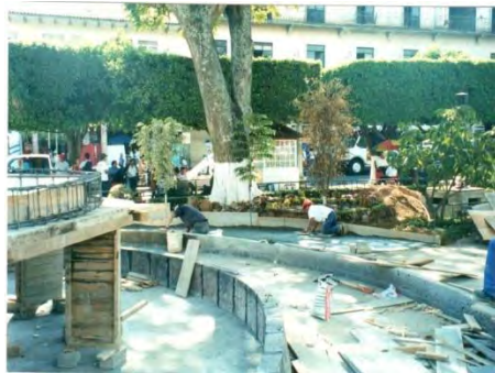
Imagen 6.103: La fuente se reconstruye de concreto armado.
