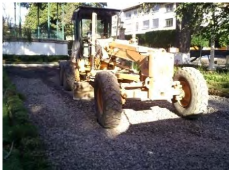
Imagen 6.95: Distribución a nivel de base hidráulica con motoniveladora.
