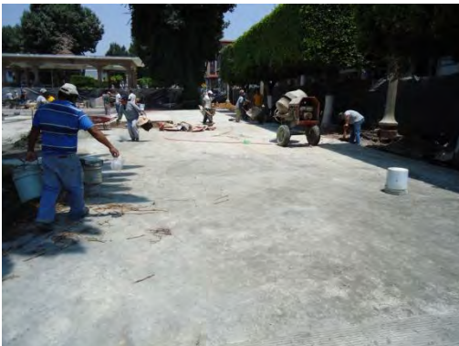
Imagen 2.35: Colado de firme de concreto para soportar las piezas de resinto.
