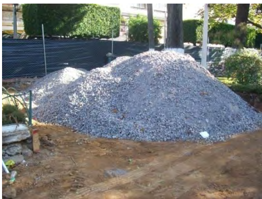
Imagen 2.33: Material graduado para mejoramiento de la superficie.
