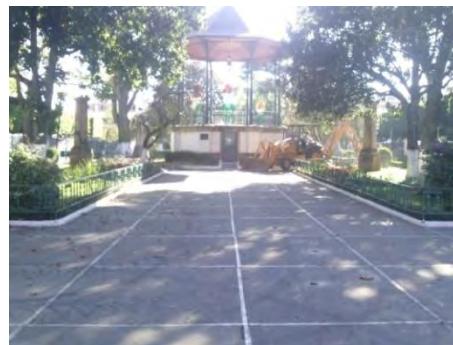
Imagen 6.84: Piso en estado previo a la demolición.
