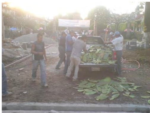
Imagen 2.45: Si se requiere penetración de agua la mezcla cementante se hará con baba de nopal.
