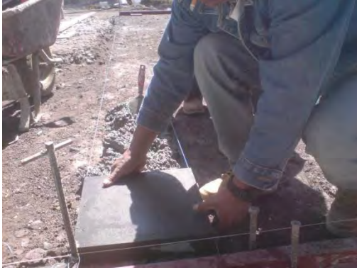
Imagen 2.37: Colocación de los hilos para acomodar las piezas de piedra de resinto.
