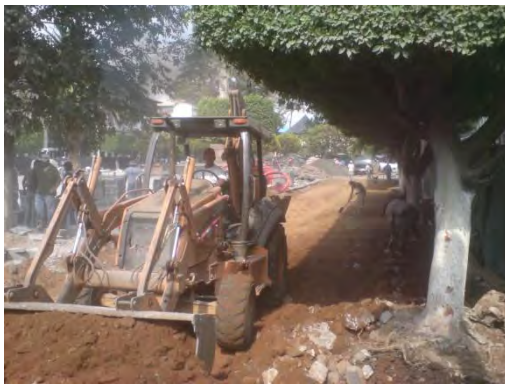
Imagen 2.31: Nivelación del terreno natural para preparar la base de agregado pétreo.
