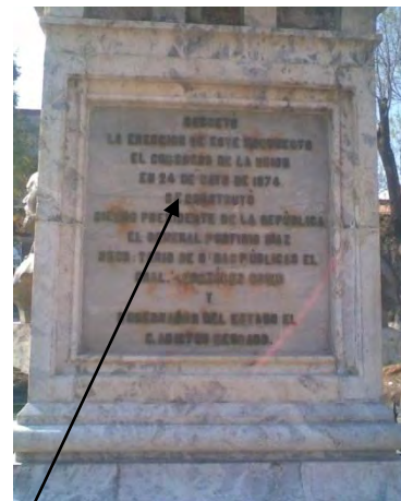
Imagen 6.107: Leyenda de fecha de construcción la cual data de 24 de Mayo de 1874.
