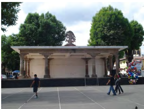
Imagen 4.63: Se muestra el deterioro del firme de concreto en la zona de explanada de la pérgola.
