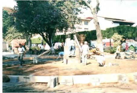
Imagen 6.102: Habilitado de material y construcción de la misma.
