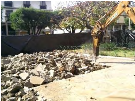
Imagen 6.85: Demolición de piso
