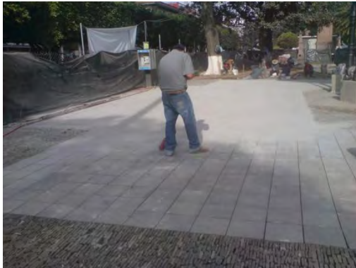
Imagen 2.39: Cernido, barrido de arena para sellado de juntas.
