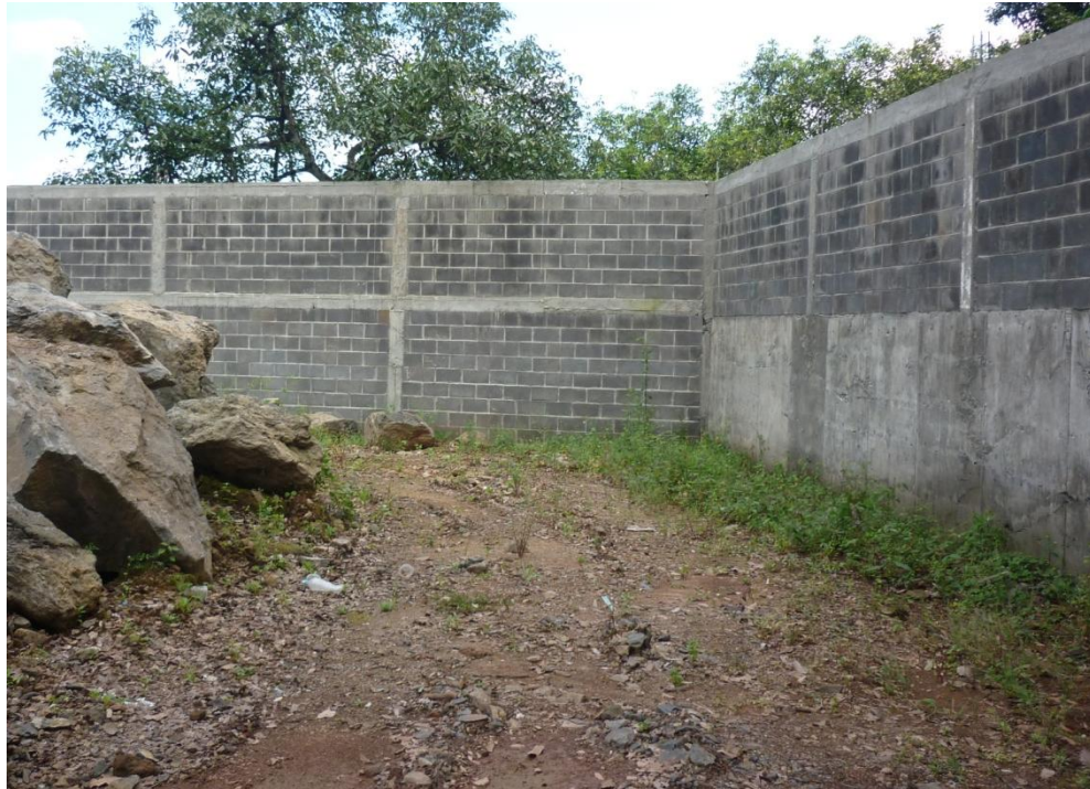
Fotografía 3.3.- Vista sur de los muros de carga para la estructura.
