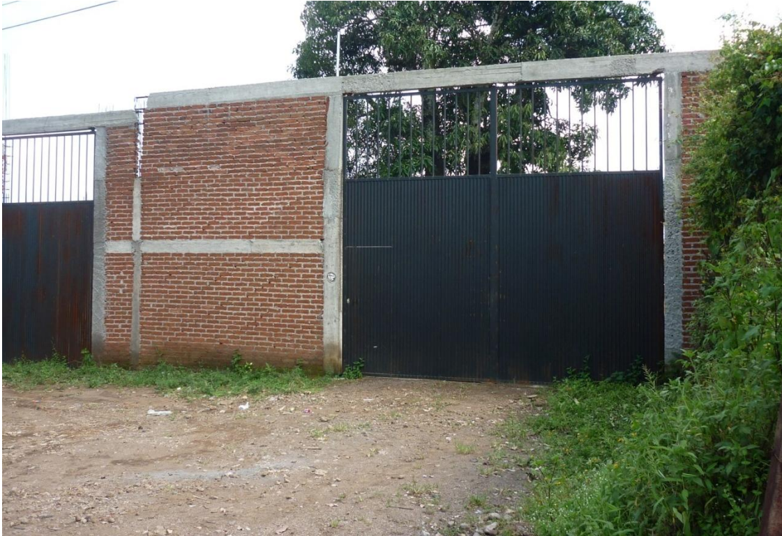
Fotografía 3.4.- Confinamiento de muros con trabe intermedia a 2.20 m de la dala de desplante.
