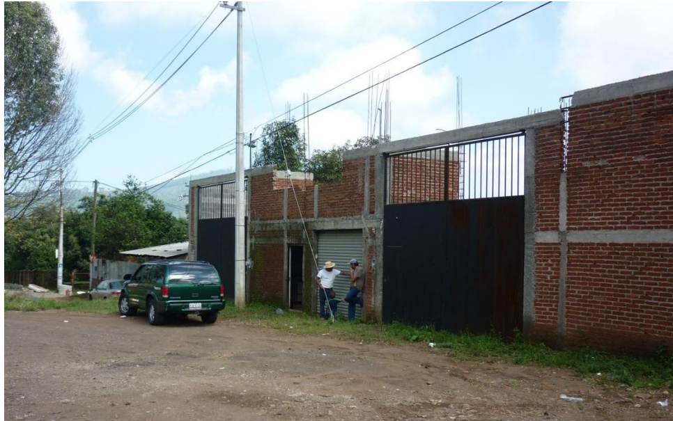
Fotografía 3.1.- Fachada frontal, se aprecia el confinamiento de los muros de carga.
