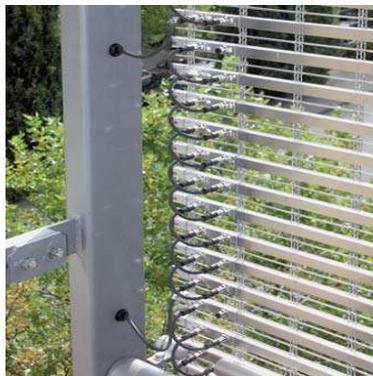
**FIGURA 81** Detalle de instalación multimedia en malla metálica
