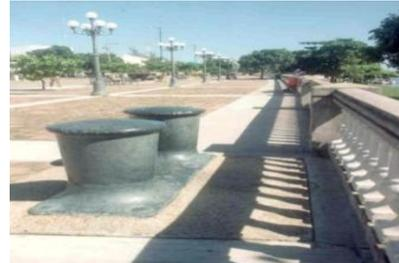
**PASEO DE LAS ESCOLLERAS:** Consiste en un andador de concreto estampado de 900 metros de longitud y 8 metros de ancho, cerca de 2 kilómetros de barandal, una glorieta de 14 metros de ancho al final del paseo, luminarias y seguridad.
