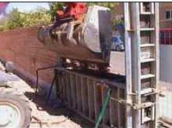
Encofrado de acero y suministro de suelo cemento.
