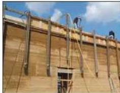
Compactación de capas a cada 25 cms de espesor con neumático.
