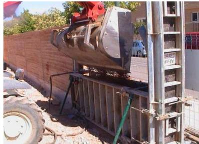
ENCOFRADO DE ACERO Y SUMINISTRO DE SUELO CEMENTO.
