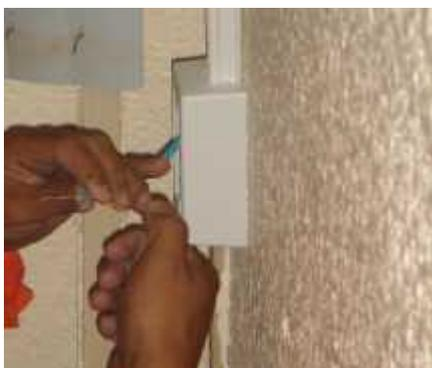
**Ilustración 3.14 separación de los hilos**
