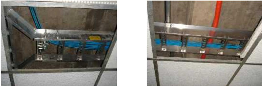
**Ilustración 3.17 planchado del cable**
