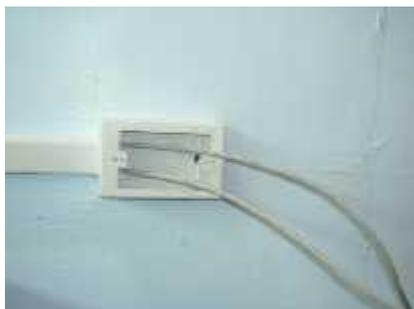
**Ilustración 3.13 roseta con cable UTP (568B)**
