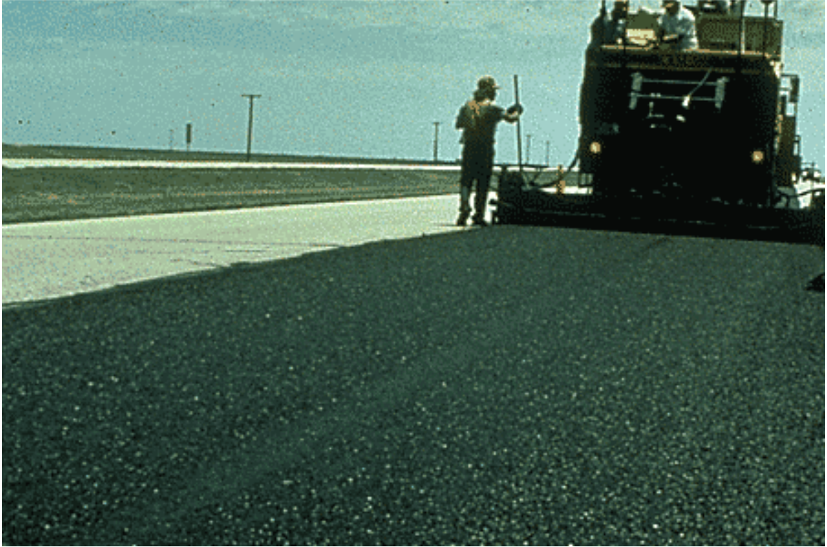
Imagen 10. Slurry Seal
