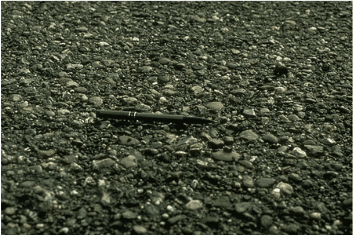
Imagen 9. Slurry Seal
