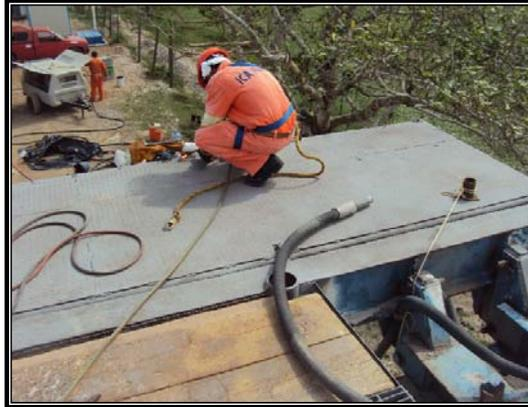
Programa de mantenimiento cambio de piso de trabajo, barandales y elementos dañados de subestructura Pozo otates 2D.
