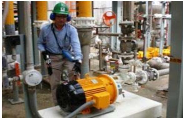
Técnico de Mexichem utilizando un detector ultrasónico para lubricar acústicamente.
