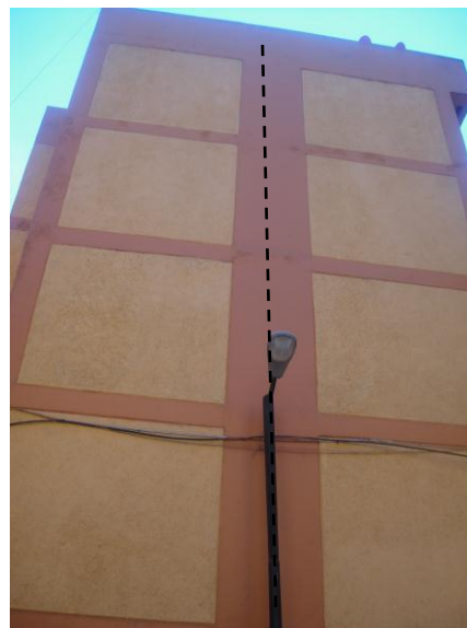
Imagen 1 y 2.- Fracturamiento con dirección NE-SW e inclinación de edificios, en la Unidad Habitacional La Concordia.
