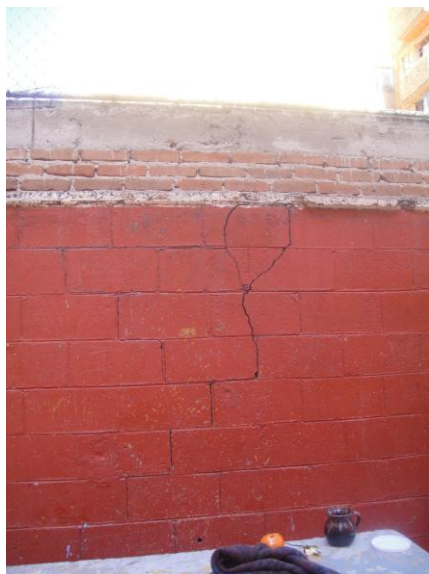
Imagen 1 y 2.- Fracturamiento con dirección NE-SW e inclinación de edificios, en la Unidad Habitacional La Concordia.
