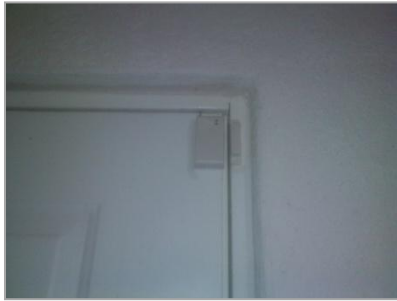
Figura 5.2 Instalación de sensores de puerta
