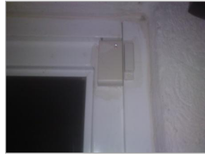
Figura 5.3 Instalación de sensores de ventana
