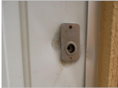
Figura 1.3 Forzando las cerraduras
