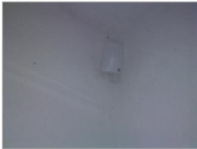
Figura 5.4 Instalación de sensores de movimiento
