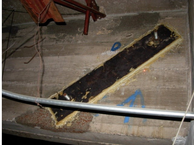
Figura 3.5 Refuerzo de cortante con solera metálica en trabes
