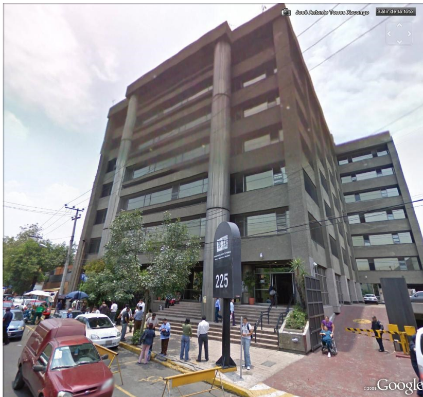
Figura 3.1 Vista de la fachada del edificio
