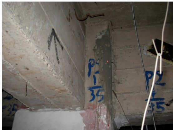
Figura 3.4 Conexión trabe-columna
