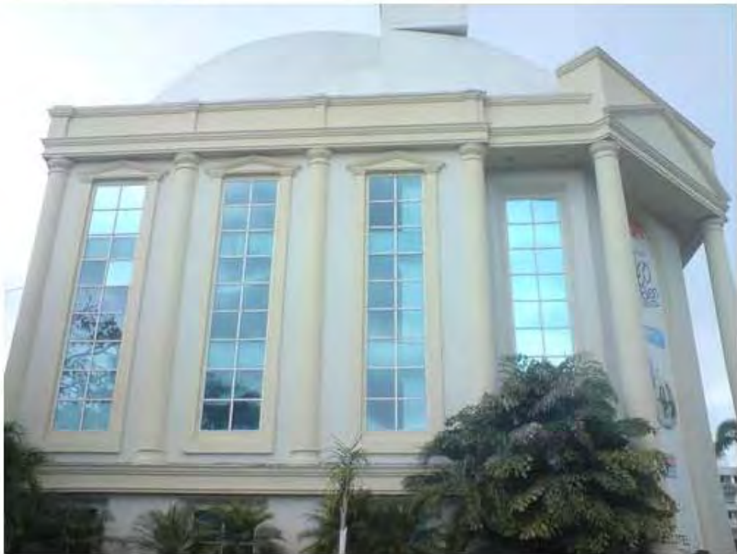
FOTOGRAFÍA 50 FACHADAS DEL EDIFICIO DE LA EMPRESA TELEFÓNICA, BARRANQUILLA – COLOMBIA - FUENTE: ARCHIVO PERSONAL DE LA AUTORA.
