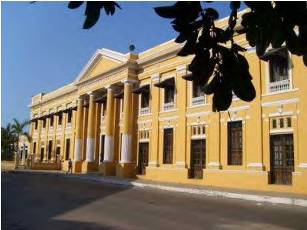
FOTOGRAFÍA 21 EDIFICIO DE LA ADUANA, BARRANQUILLA – COLOMBIA - FUENTE: ARCHIVO PERSONAL DE LA AUTORA
