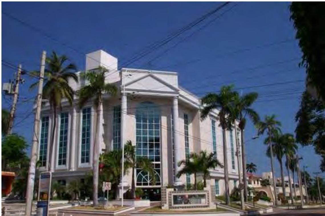
FOTOGRAFÍA 49. FACHADA PRINCIPAL DE LA EMPRESA DE TELÉFONOS. FUENTE. ARCHIVO PERSONAL DE LA AUTORA
