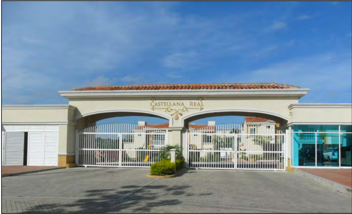
FOTOGRAFÍA 53. ACCESO AL CONJUNTO CERRADO CASTELLANA REAL. FUENTE. ARCHIVO PERSONAL DE LA AUTORA.
