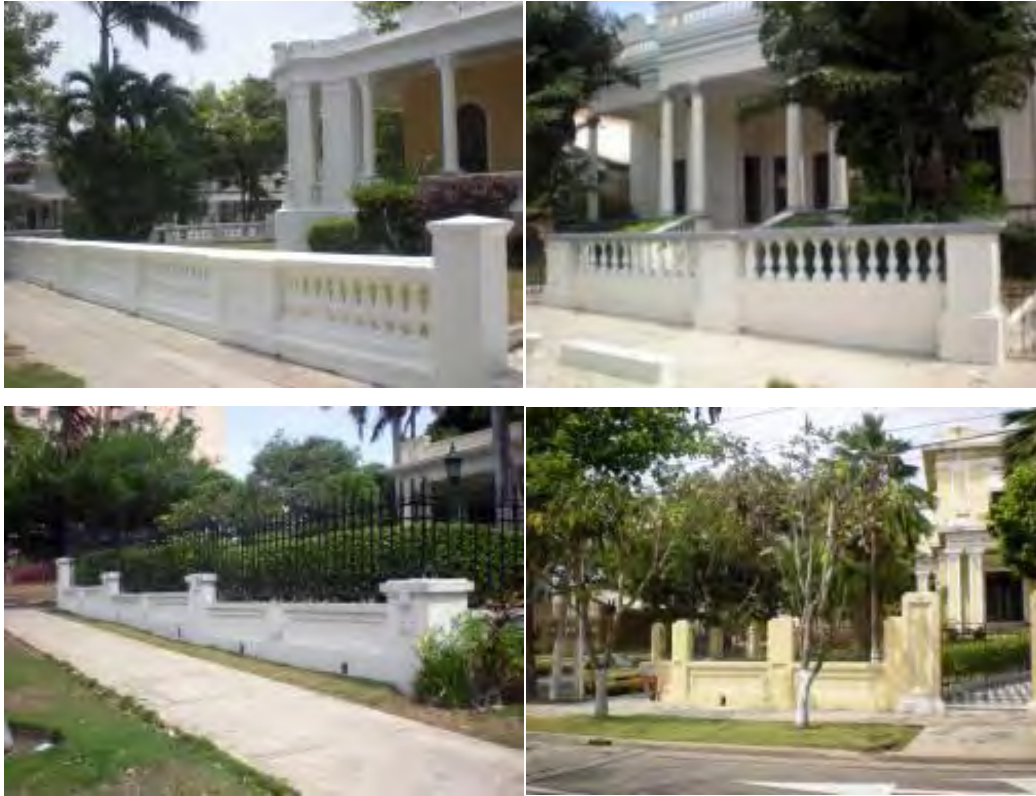
FOTOGRAFÍA 35 CERRAMIENTOS DE LAS VIVIENDAS DEL BARRIO EL PRADO - FUENTE: ARCHIVO PERSONAL DE LA AUTORA
