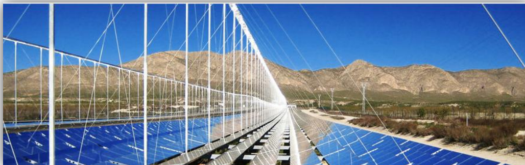
Fig. 2.7. Primera planta solar comercial de fresnel lineal de 1.4 MWe de la empresa Novatec Biosol (Murcia, España).
