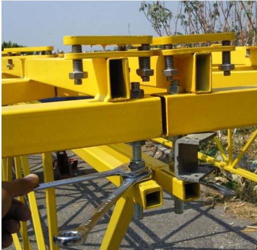
Fig. 4.6. Ajuste de altura de las facetas.
