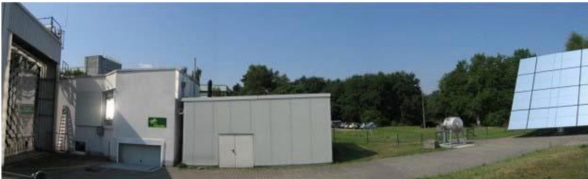
Fig. 2.13. Instalaciones del horno solar de Colonia, Alemania. De izquierda a derecha se observa: el concentrador, el laboratorio donde se encuentra el punto focal y el helióstato.
