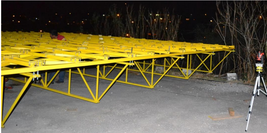
Fig. 4.10. Montaje del láser y las escuadras para la alineación de platinas.
