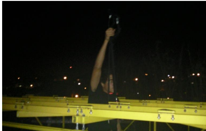
Fig. 4.12. Verificación de la planitud de las platinas.
