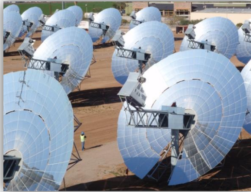
Fig. 2.8. Planta solar Maricopa de 1.5 MWe compuesta por 60 receptores (Arizona, E.U.A.).
