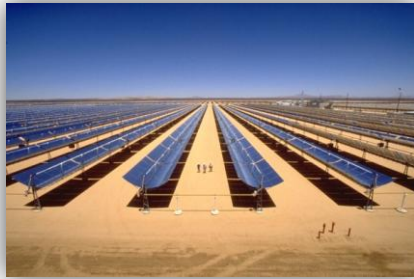
Fig. 2.5. Complejo de plantas SEGS (Solar Electric Generating Systems) de 354 MWe de capacidad en el desierto de Mohave, (California, E.U.A).
