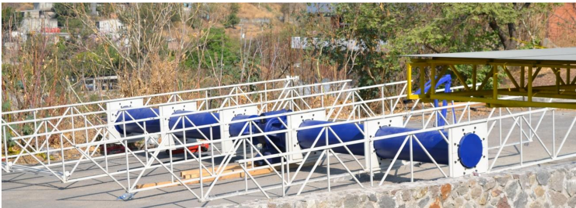
Fig. 4.5. Heliostato sin ensamblaje de las facetas.
