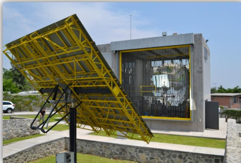
Fig. 2.16. Instalaciones del horno solar de 30 kW t en el CIE-UNAM en Morelos, México.
