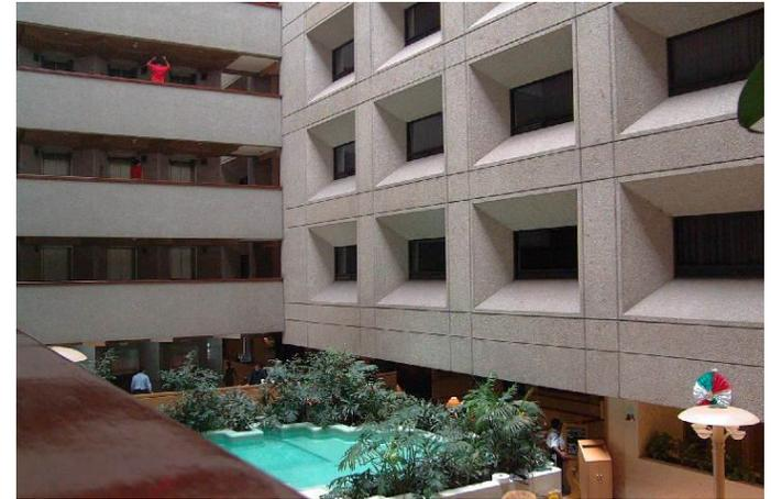
La superestructura fue una obra colada en el sitio, con concretos premezclados, de una resistencia de 250 k/cm<sup>2</sup>
