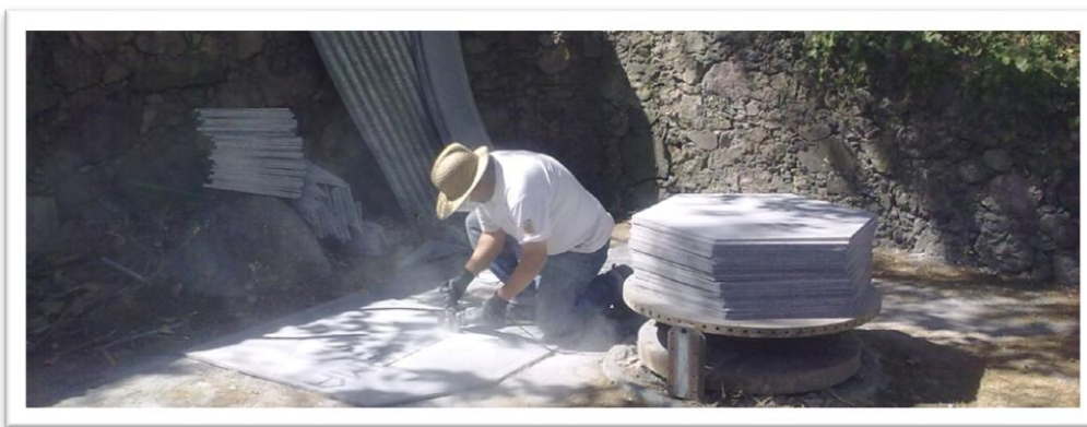
Imagen 82: Recorte de los paneles de tabla concreto en formas hexagonales.
