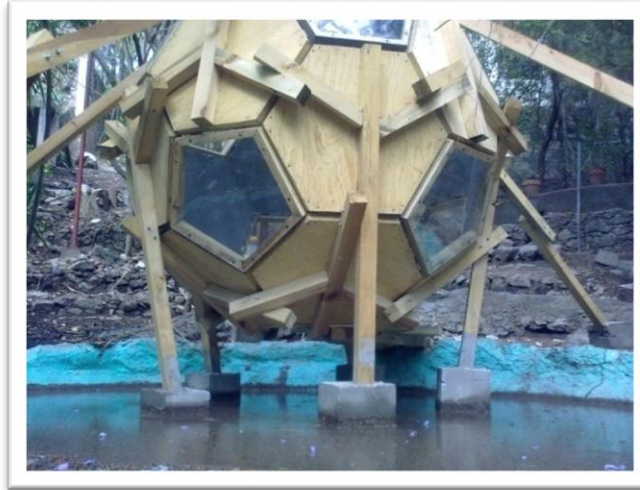
Imagen 86: Restauración del estanque en las instalaciones de la ENAP Taxco.
