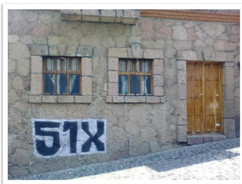
Imagen 27: Fachadas donde el acabado exterior está íntimamente ligado con los procesos constructivos
