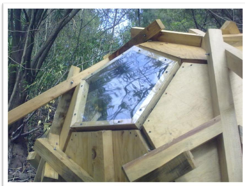
Imagen 83: Aplicación del acrílico en el refugio.
