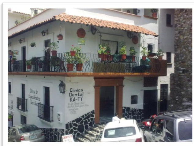
Imagen 26: Solución de rodapiés y aplanados extremadamente difundida en Taxco
