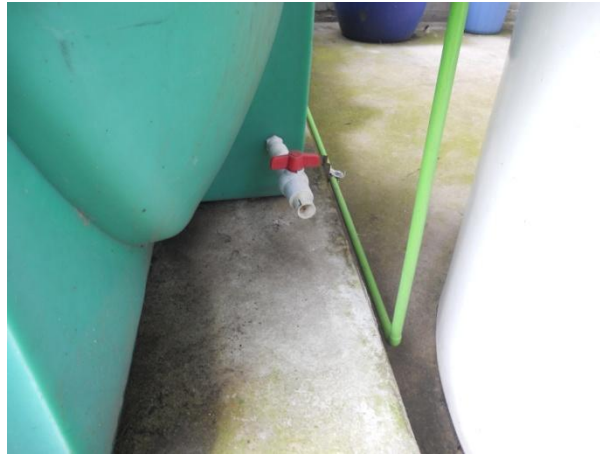
Figura 3.6 Detalle de válvula de purga.
