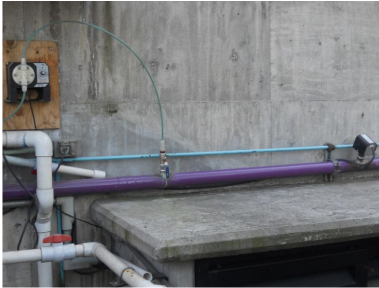
Figura 3.14 Bomba dosificadora (izquierda) y detector de flujo (derecha).
