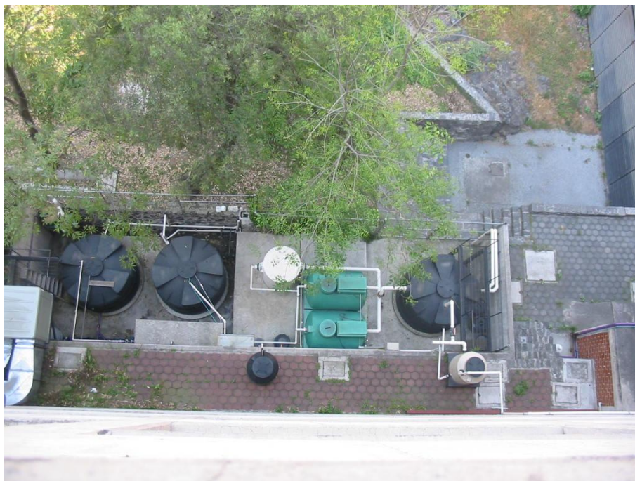
Figura 3.16 Vista aérea de la PTAR.
