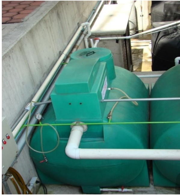
Figura 3.5 Detalle de una planta paquete.
