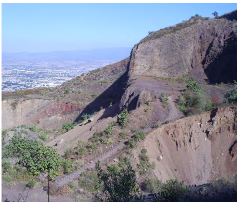
FotoV-4. En esta parte se ve la disposición de los cortes para la extracción de materiales y el peligro de derrumbes, debido a su inestabilidad.
