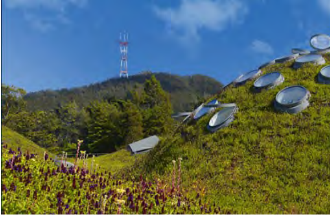
Fig. 34. Nuevo edificio de la Academia de Ciencias de California. Arq. Renzo Piano. Golden Gate Park, EUA, 2010.
