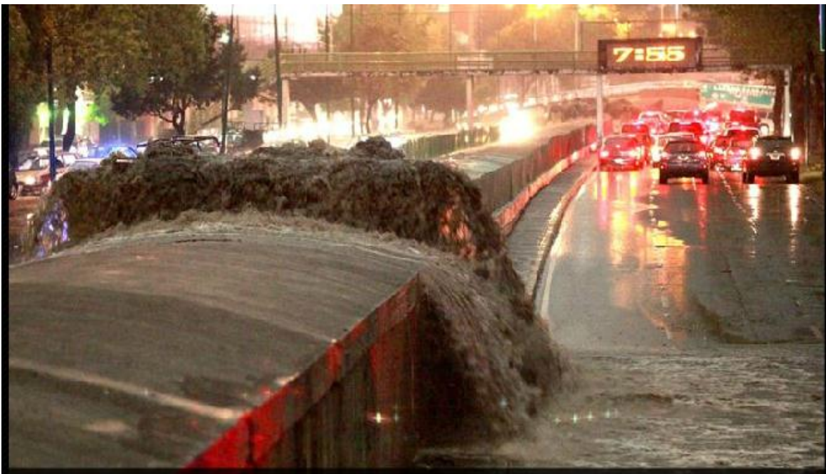
Se presume que la fuerza del agua del drenaje provocó grietas en el ducto que atraviesa la avenida. EL UNIVERSAL
