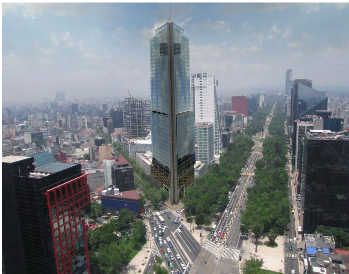
Figura 45 Imagen virtual de Punta Reforma, Reforma 180. (En construcción), Imagen: http://www.grupoamc.com/puntareforma.htm
