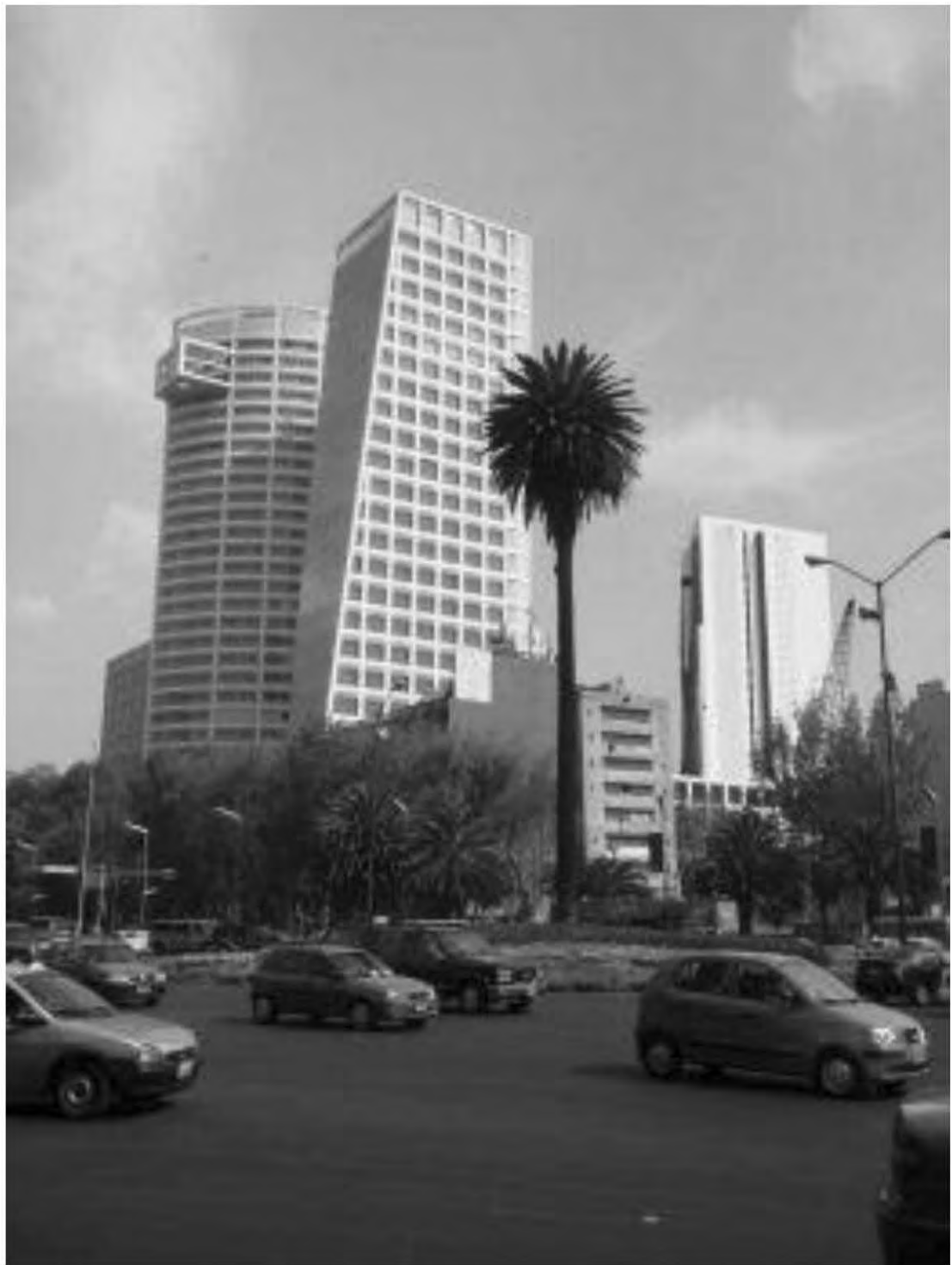
Figura 43 Reforma 222. Concluido en 2008. Fuente: Imagen de la autora.
