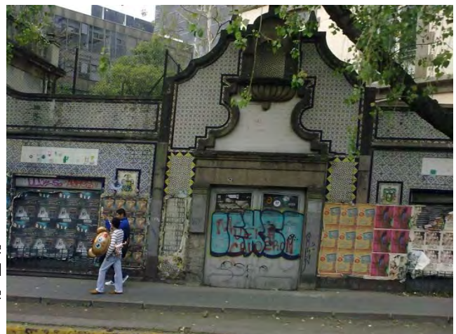
Figura 49. Misma mansión en su vista que da a la Av. Insurgentes, se aprecia el deterioro del inmueble. Imagen: propia de la autora.
