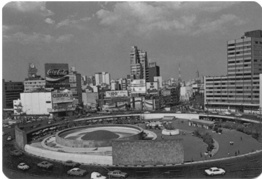
Figura 31 Glorieta de los Insurgentes ya finalizada su construcción, en la imagen se puede observar la entrada del Cine Insurgentes después de la modificación que sufrió para la adecuación de la glorieta. Imagen: Memoria Metro de la Ciudad de México.
