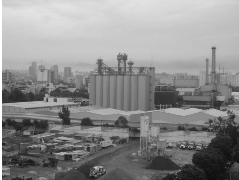
Figura 7 Instalaciones de la Cervecería Modelo en la colonia Anáhuac de la Ciudad de México. Imagen de la autora.
