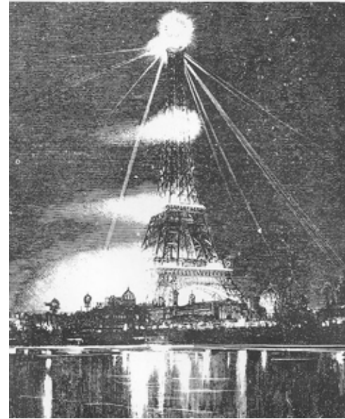
La torre Eiffel. De hierro pudelado construido con un sistema de barra transversal realizado de. La estructura de la obra maestra de Gustave Eiffel es muy espaciosa y resistente al viento (18.038 piezas y se fija con 2.500.000 remaches). Pesa 7.300 toneladas. Mide en la actualidad, 324 metros de altura con antenas.
