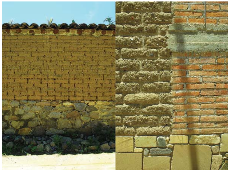
Fig. 71 Izquierda: Materiales usados tradicionalmente en las viviendas vernáculas. Derecha: Nuevos materiales que se usan en las viviendas vernáculas.
