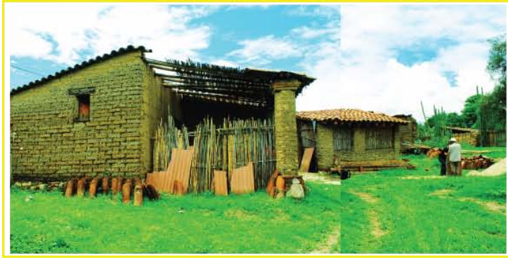
Vista 1: Patio y espacios comodines donde todavía se alcanza a ver los materiales y desechos en la reconstrucción de la futura cocina.
