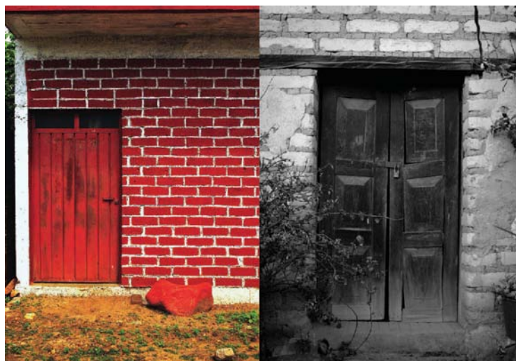
Fig. 70 Derecha: Vivienda Vernácula de los Valles centrales, de adobe y madera. Izquierda: Vivienda Vernácula de los Valles centrales de block y cemento.
