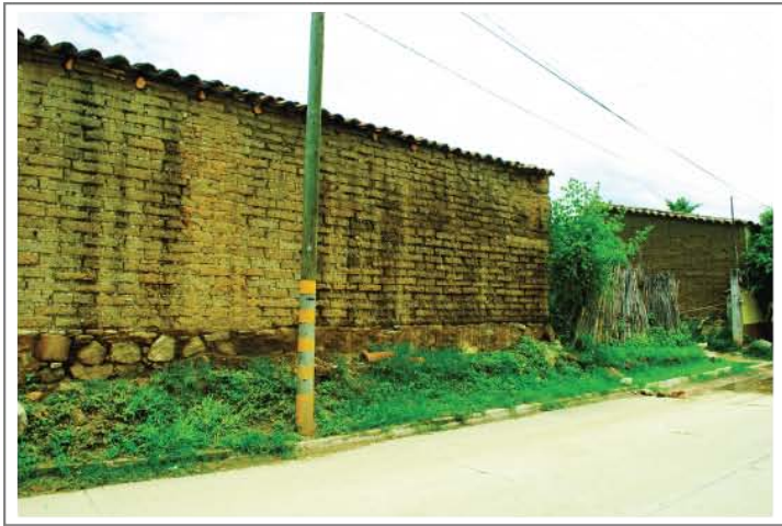
Vista 1: Fachada exterior donde se observa un muro ciego a la calle, que es el comedor reconstruido.
