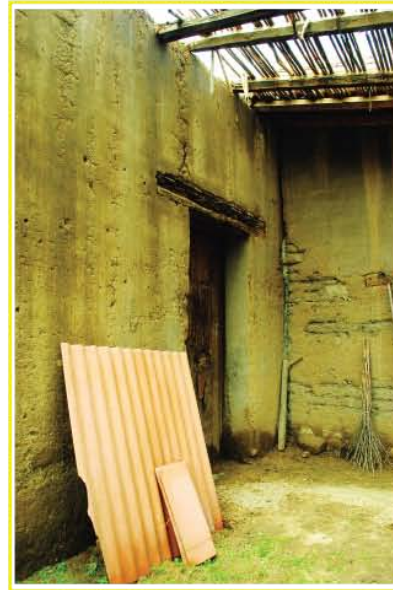
Vista 4: Entrada desde el pórtico a la habitación reconstruida, con algunos desechos que todavía quedan de la construcción pasada.
