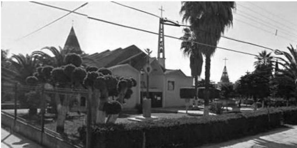
Imagen 4.4, Construcción vecina al terreno del proyecto
