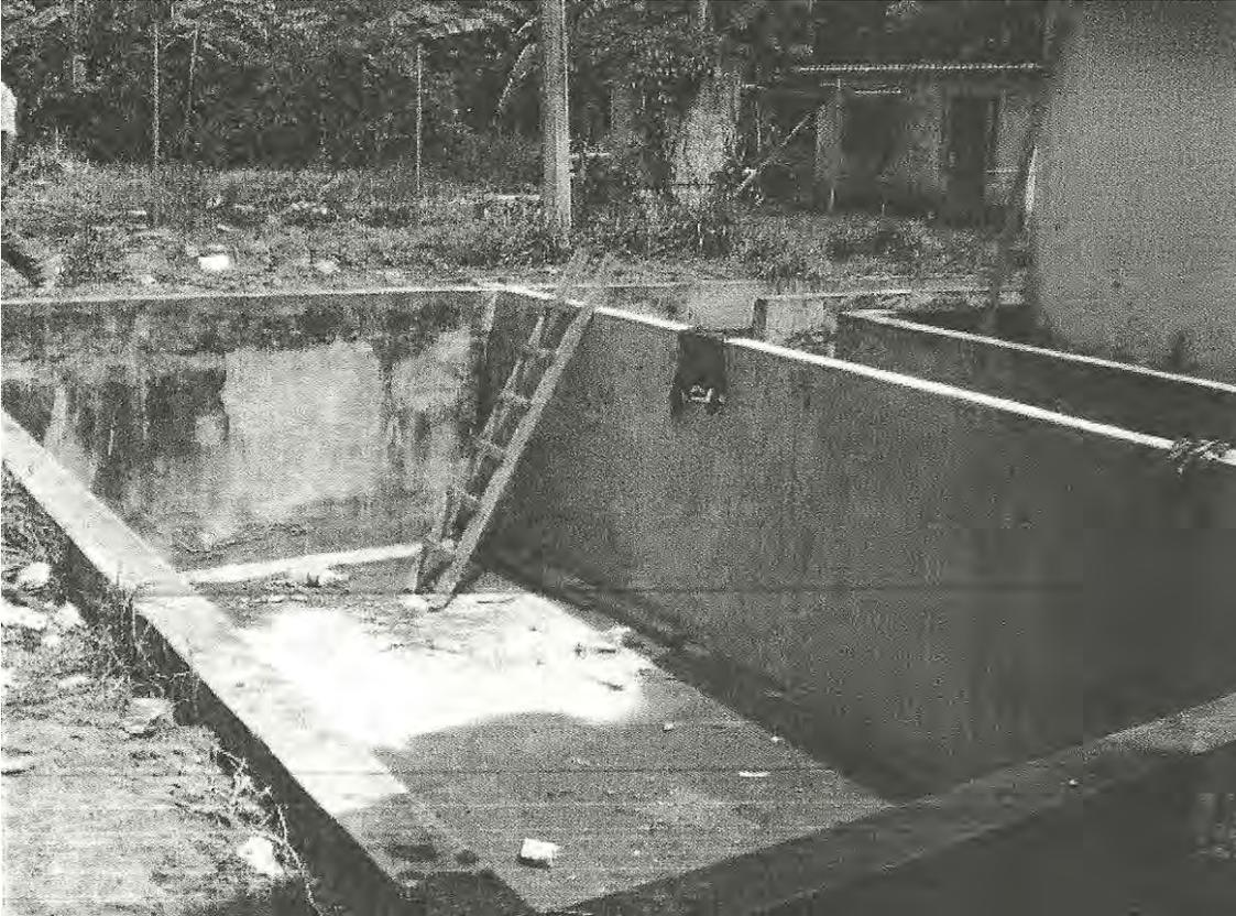
**FIGURA 14. Cárcamo de bombeo de agua residuales crudas.**
