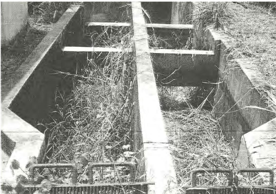
**FIGURA 13. Desarenadores hidráulicos**
