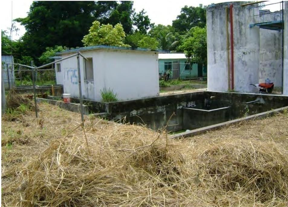
**FIGURA 7. Vista del pre-tratamiento y el cárcamo de bombeo de aguas residuales crudas.**
