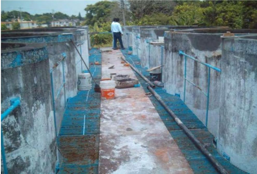
**FIGURA 9. Vista de daños en los tanques aireadores, clarificadores y digester de lodos desde el pasillo elevado de operación.**
