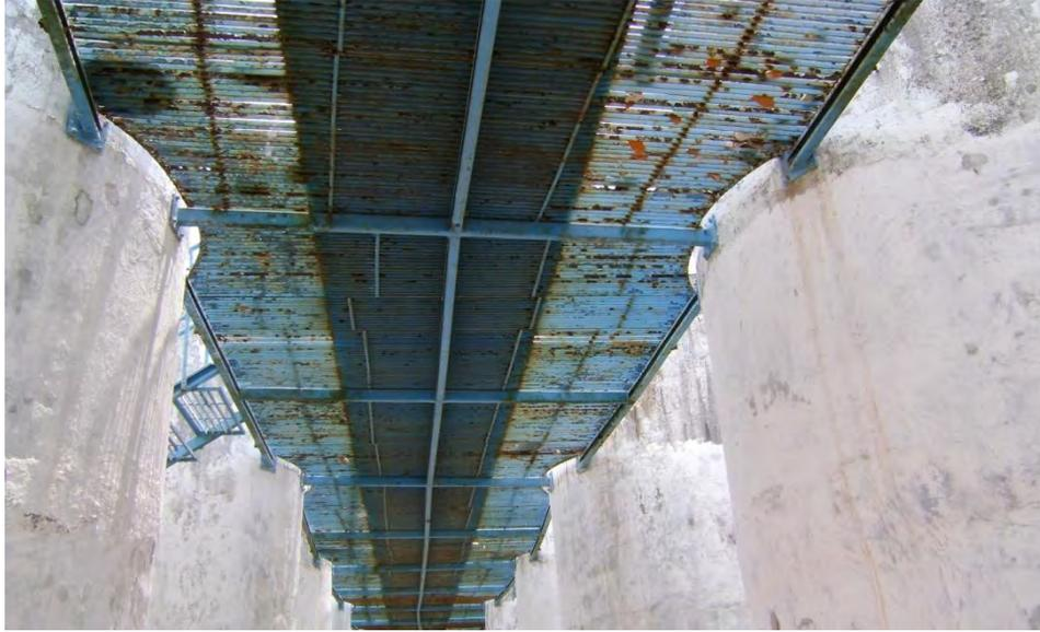
Figura 5. Vista de los tanques aireadores donde se logra apreciar el daño debajo del pasillo elevado de operación.
