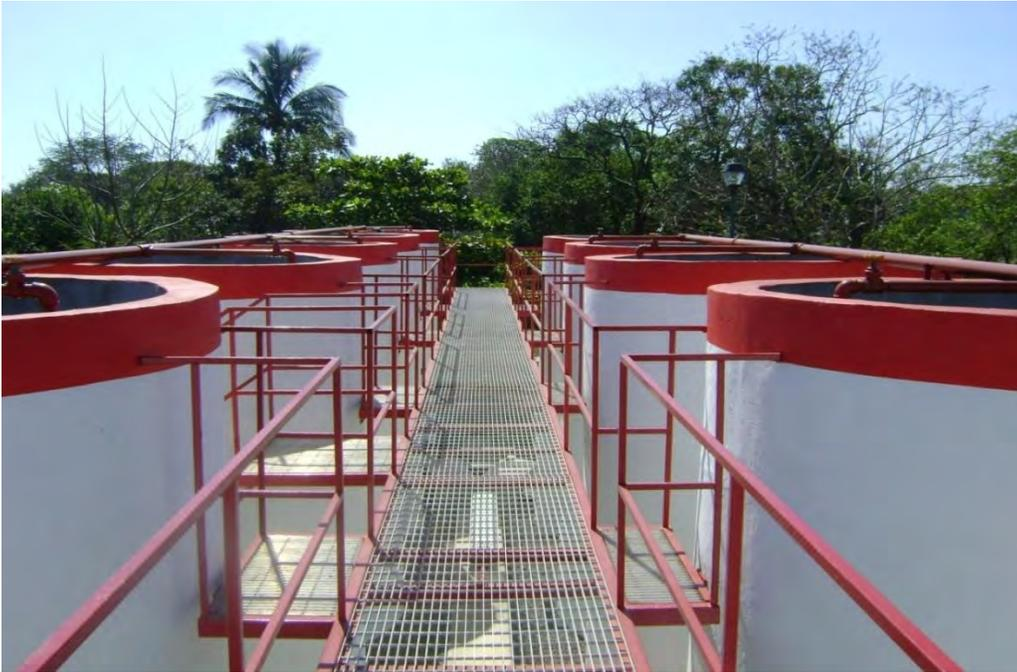
**FIGURA 22.**Vista de los tanques aireadores, clarificadores y digester de lodos desde el pasillo elevado de operación en su proceso de reactivación.
