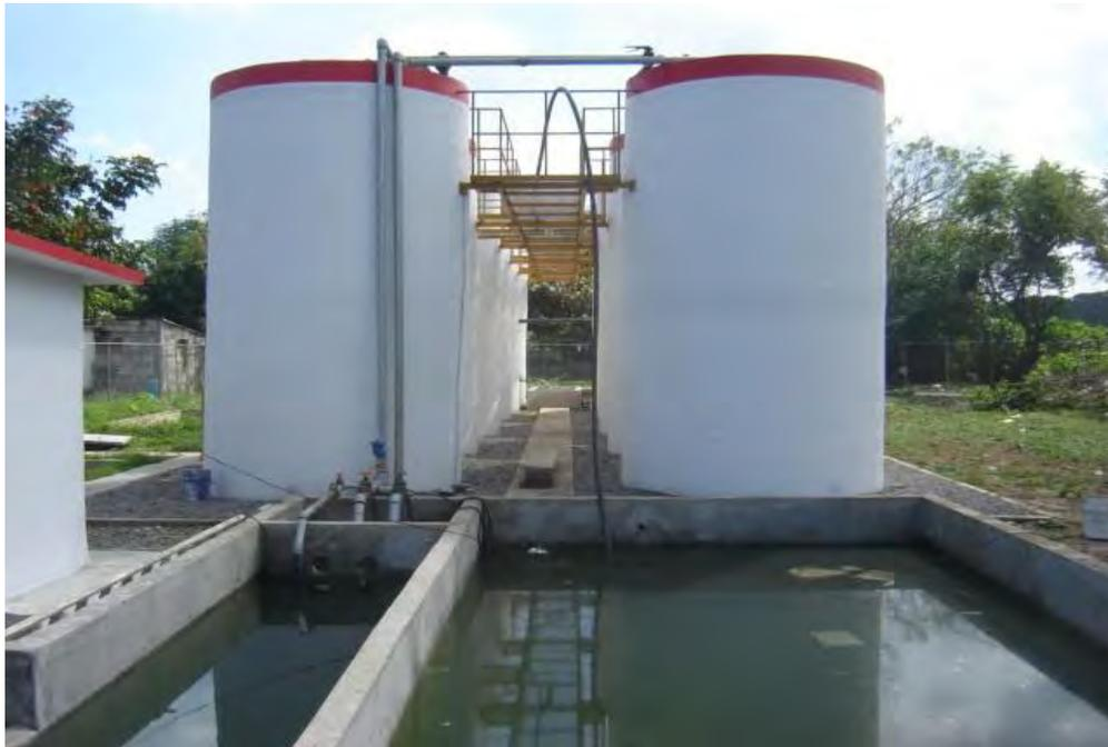
**FIGURA 23.**Vista del pre-tratamiento y el cárcamo de bombeo de aguas residuales crudas en su proceso de reactivación.
