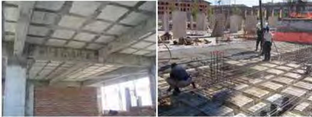
FIGURA 58. Acabado y armado de una losa reticular.
