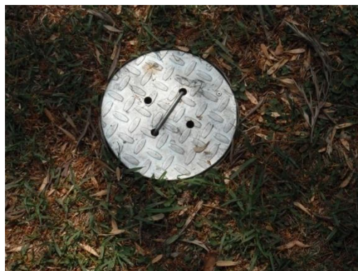
FIGURA 7 SE COLOCÓ UNA TAPA PARA SU UBICACIÓN Y MANTENIMIENTO
