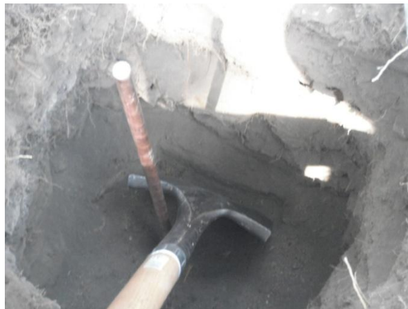
FIGURA 4 COLOCACIÓN DE LA VARILLA
