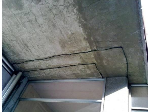
FIGURA 3 CABLE DE TIERR FISICA
