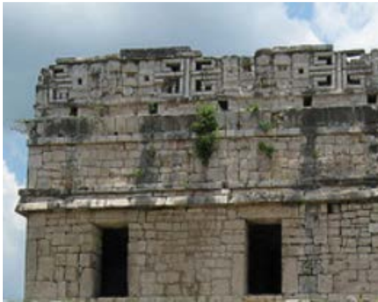
Ilustración 1: Ala norte del Akab-Dzib, con restos de la crestería
