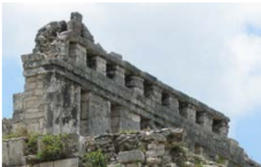
Ilustración 15: Detalle de la crestería antigua; con aberturas en la base y decoración de grecas entre las cornisas
