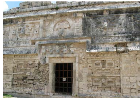
Ilustración 37: Detalle de la decoración en la fachada del Anexo del Este
