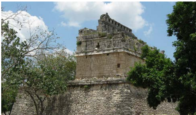
Ilustración 13: Vista posterior izquierda en donde se aprecia la crestería en la parte central del techo
