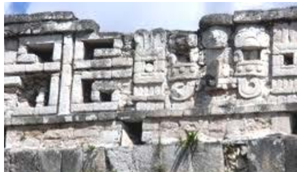
Ilustración 16: Detalle de la crestería al frente de la fachada; mascarón del dios Chac y grecas intercaladas
