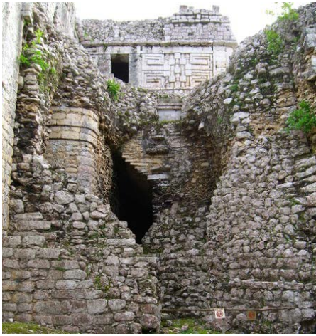
Ilustración 32: Detalle donde se aprecia el primer basamento con las esquinas redondeadas y posteriormente la superposición del segundo basamento
