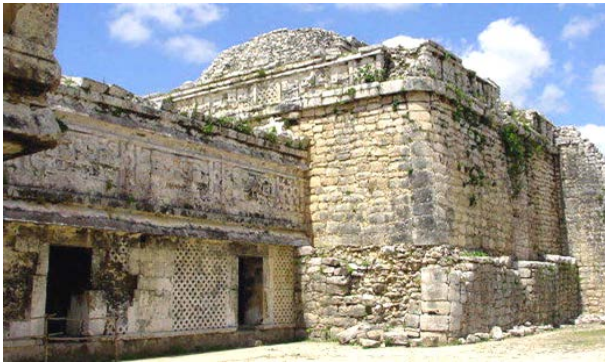
Ilustración 34: Vista del lado norte del Anexo del Este, a la derecha, el basamento de Las Monjas
