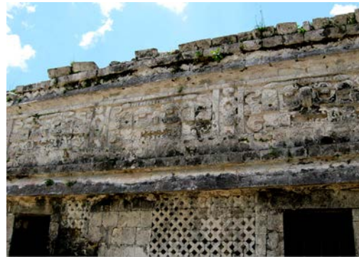
Ilustración 35: Detalle de la decoración con paneles de rejilla en la pared y mascarones del dios Chac en la moldura-cornisa
