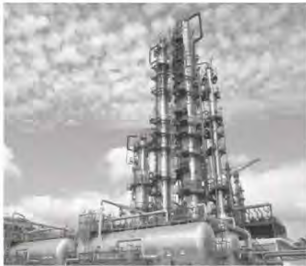
13. El primer paso en el proceso de refinación, es la destilación atmosférica realizada en las unidades de crudo.
