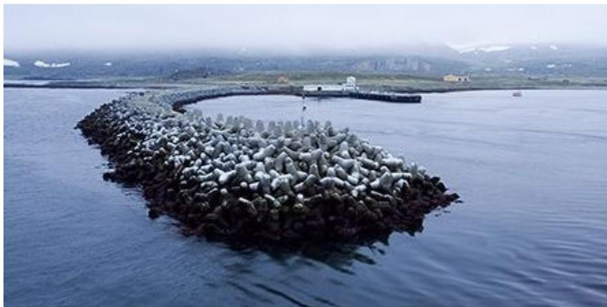
Fig. 3 Escollera conformada por tetrápodos
