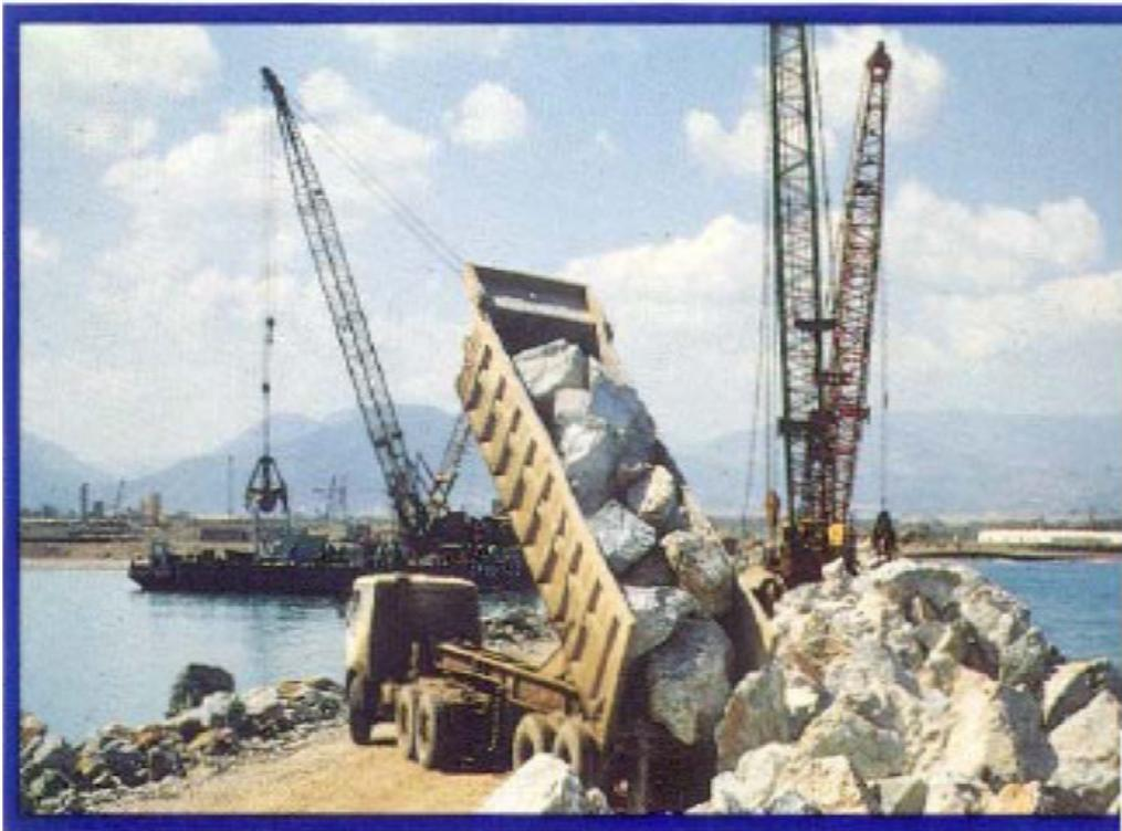
Fig. 15 Descarga de material producto de banco de materiales
