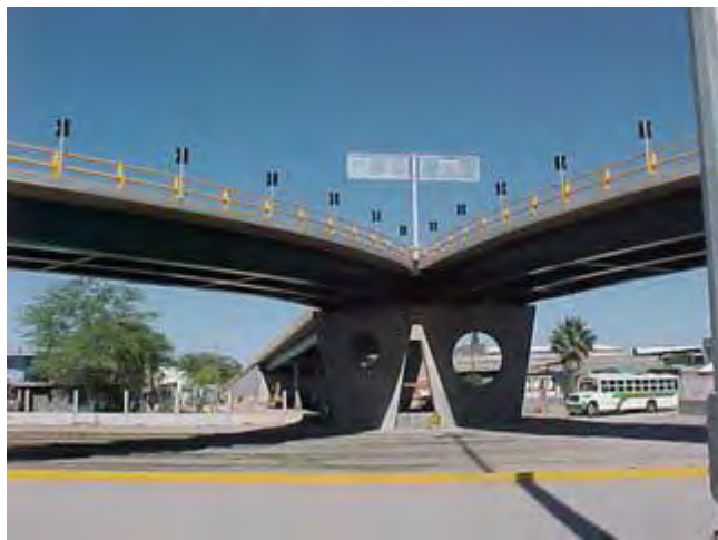
ILUSTRACIÓN 7: PASO A DESNIVEL EN TORREÓN. INTERSECCIÓN ENTRE AVENIDA Y LA LÍNEA A.
