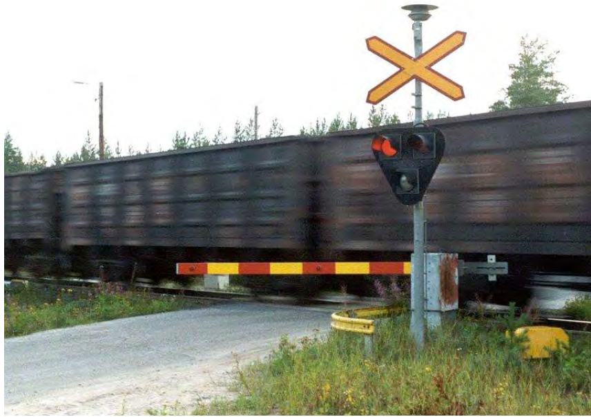
ILUSTRACIÓN 6: PASO A NIVEL CON SEÑALAMIENTO Y PLUMA.
