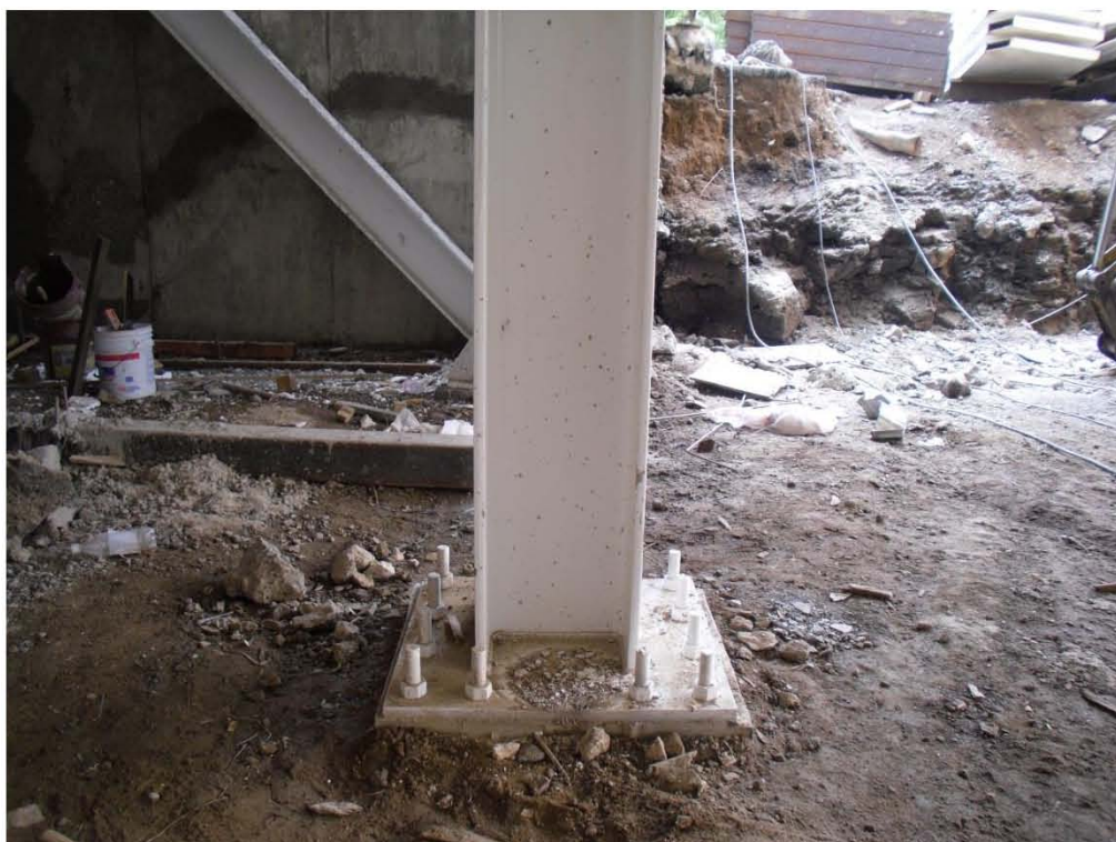
Placa base para columna cargada axialmente y sometida a excentricidad.
