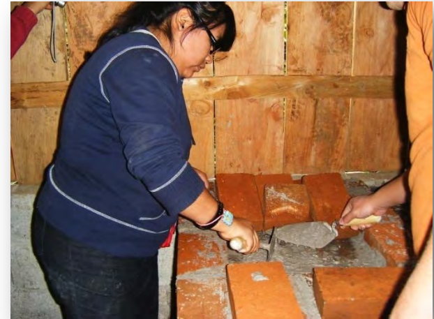
Imagen 51. Construcción de Estufa de leña
