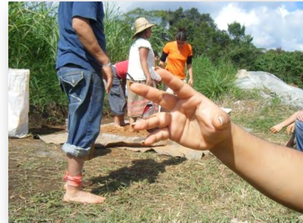
Imagen 15. Construyendo con tierra
