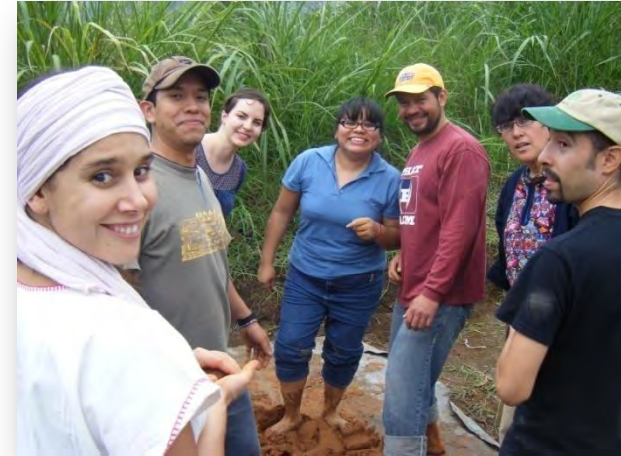
Imagen 12. Construyendo con Cob
