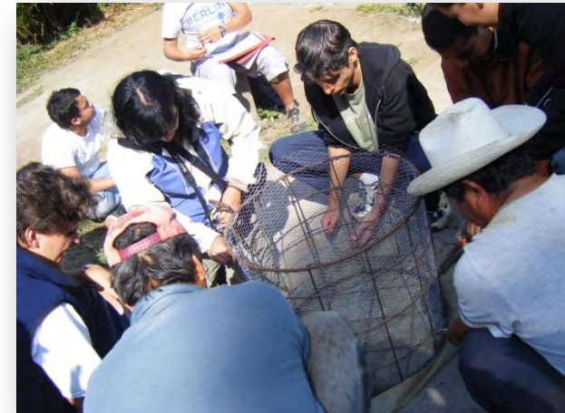
Imagen 55. Construcción modelo de Cisterna
