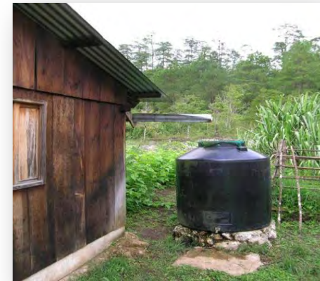
Imagen 46. Captación de Agua
