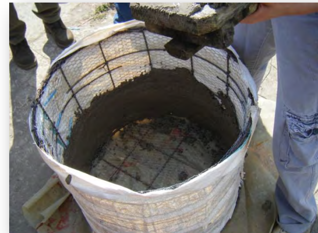
Imagen 56. Construcción modelo de Cisterna
