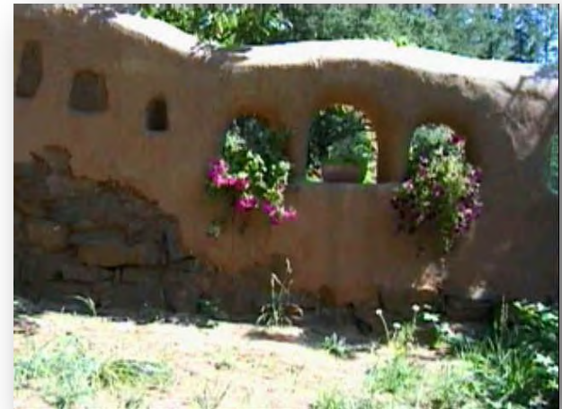
Imagen 23. Construcción en Cob
