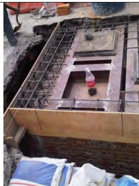
Construcción de cajas de válvulas.
