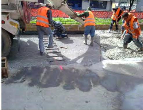
Colocación de la barras pasajuntas.
