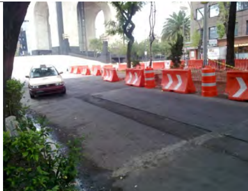
Zona de los trabajos confinada mediante barreras y Trafitambos.
