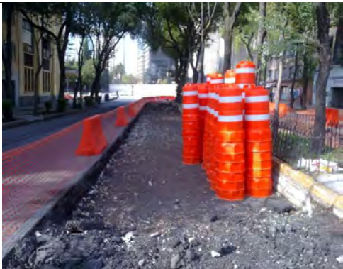
Trafitambos para confinamiento de las zonas de los trabajos.
