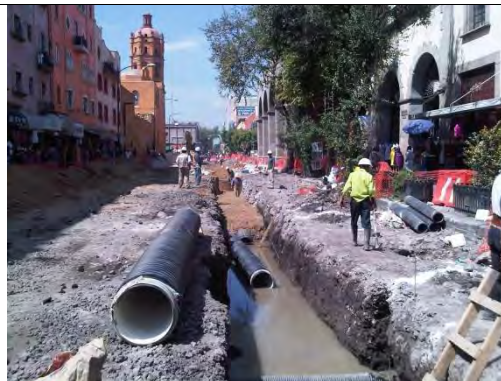
Zanja para alojar tubería de drenaje.
