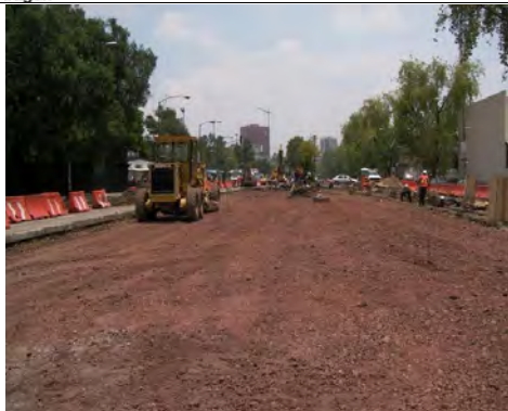
Tendido del tezontle 15 cm conforme a proyecto.
