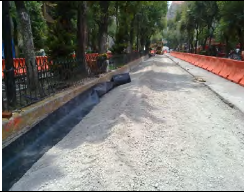
Colocación de la membrana impermeable, colocada entre guarnición existente y losa de concreto MR.
