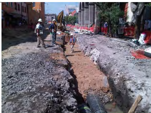
Relleno de zanja con material de banco tepetate.
