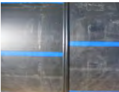
Figura III.9 Soldadura de la tubería de PAD
