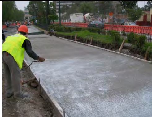
Curado de la losa de concreto hidráulico MR.
