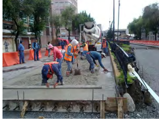
Vista de la cimbra y de las barras pasajuntas.
