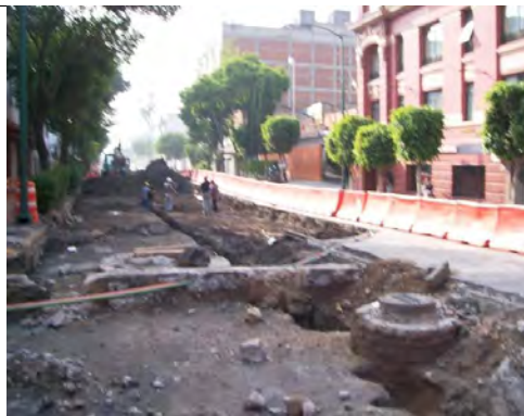
Excavación de zanja para alojar tubería de A.P.
