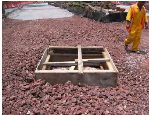
Frontera para proteger los pozos de visita, cajas de válvulas, etc., para evitar que se introduzca material.
