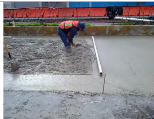
Vista del colado de la losa de concreto hidráulico MR.
