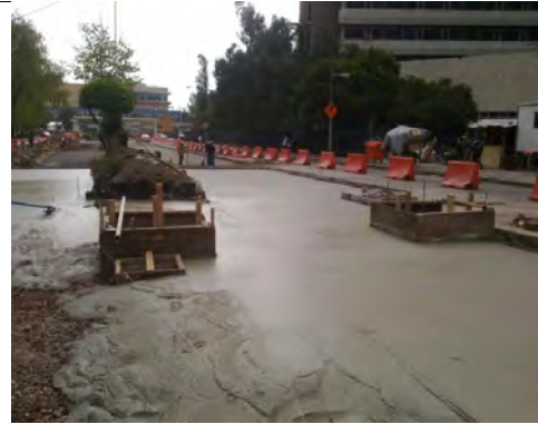
Colado a base de relleno fluido calidad sub-base.
