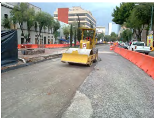
Compactación de la sub-base con vibrocompactadora.
