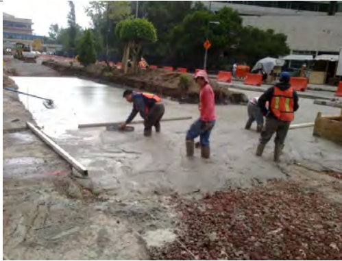
Colado a base de relleno fluido calidad sub-base.
