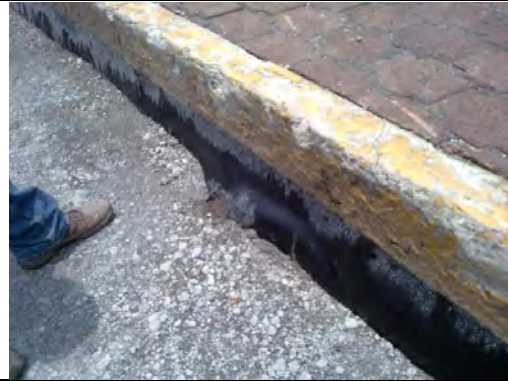
Colocación de la membrana impermeable, colocada entre guarnición existente y losa de concreto MR.
