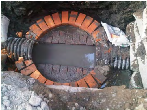
Construcción de los pozos de visita y colocación de escalones.
