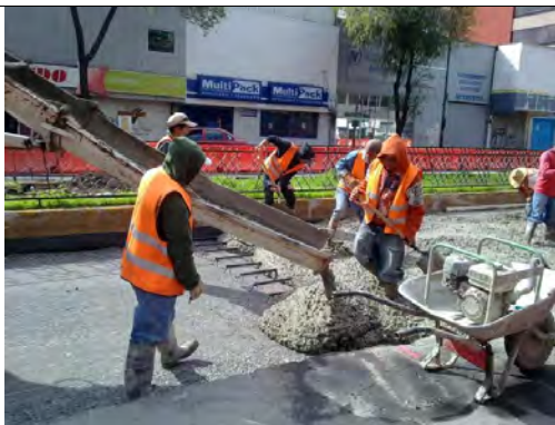
Vista del colado de la losa de concreto hidráulico MR.
