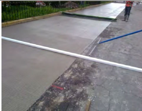
Texturizado de la losa de concreto hidráulico MR.
