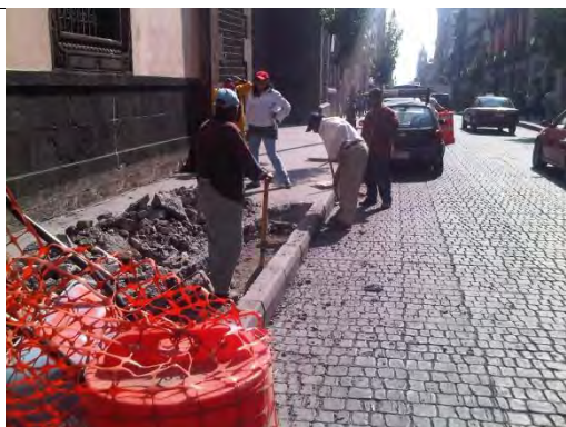
Demolición de banqueta para la construcción de una parada de Metrobús
