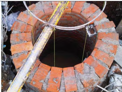
Construcción de los pozos de visita y colocación de escalones.
