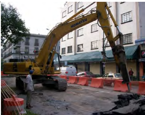
Demolición de la carpeta asfáltica existente y trazo de la trayectoria de la tubería de agua potable.
