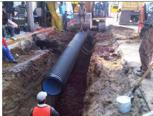
Maquina retroexcavadora maniobrando con la tubería de drenaje.
