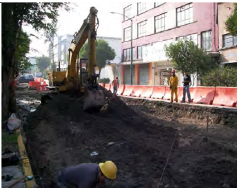
Retiro del material producto de la excavación.
