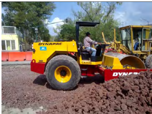
Paso del vibro para un mejor acomodo de la capa de tezontle.
