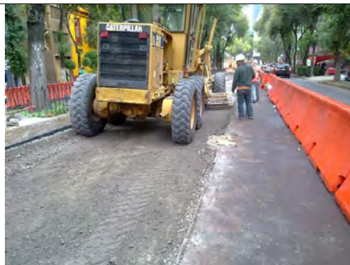
Conformación de la capa sub-base de grava-cemento.
