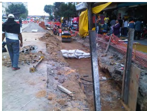
Compactación de tepetate en zanja.
