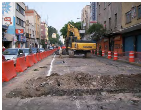
Demolición de la carpeta asfáltica existente y trazo de la trayectoria de la tubería de agua potable.
