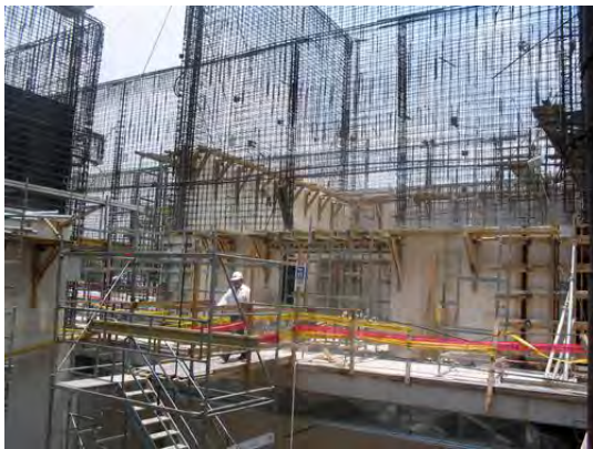
Recubrimiento de los muros.
