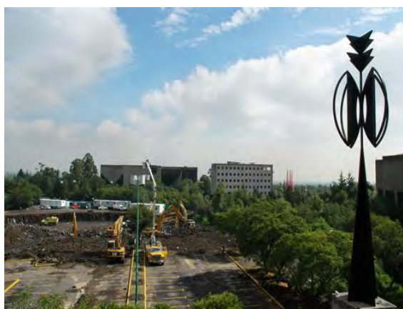
Retiro de las luminarias y árboles.
