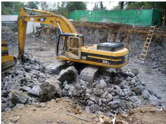
Inicio de la excavación.
