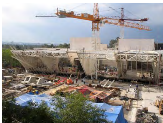
Vista frontal exterior.
