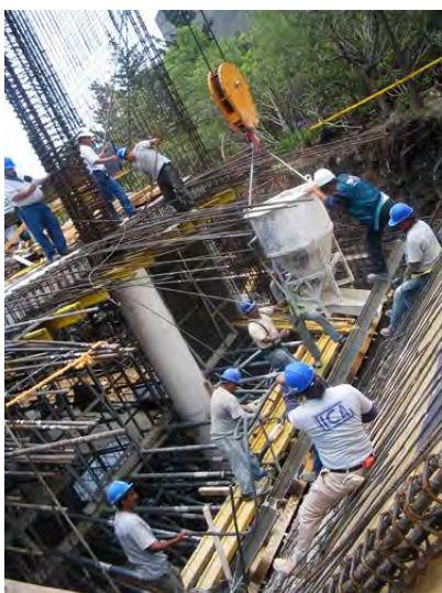
Colado de los muros.
