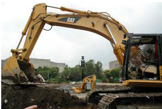
Excavación e inicio de la cimentación.
