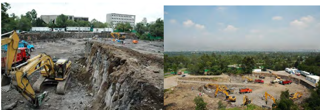
Proceso de excavación.
