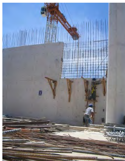
Colocación del concreto blanco. Fotos: Verónica Rosales.
