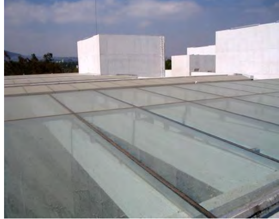
Vista del techo de las salas con luz natural. Fotos: Verónica Rosales.
