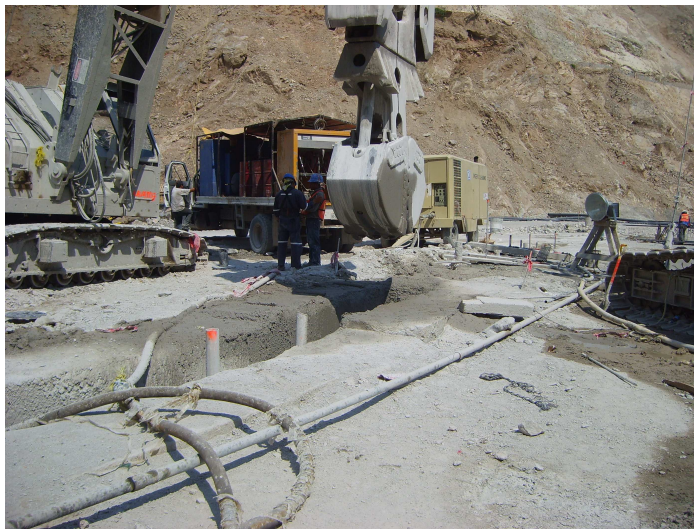
Fotografía 1. Excavación de zanja.
