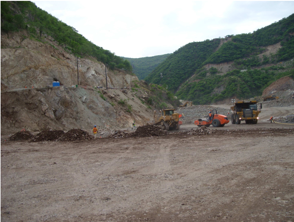
Fotografía Vista de la zona donde quedará la ataguía de aguas abajo.
