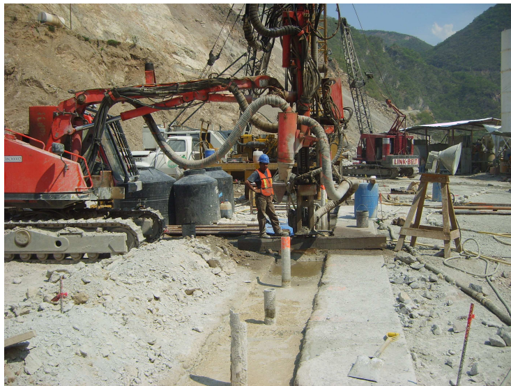
Fotografía 2. Perforación para la inyección.
