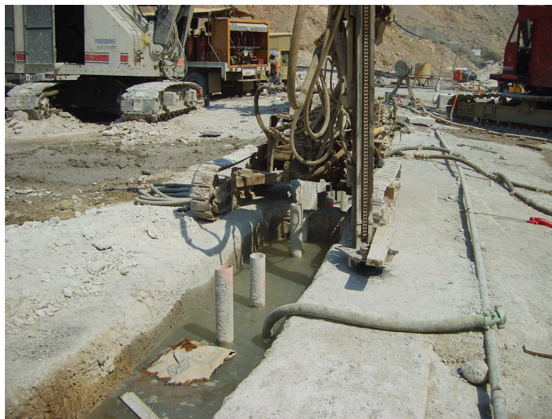
Fotografía 3. Ejemplo de inyección de mezcla.
