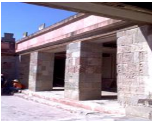
Pilares que rodean el patio.
