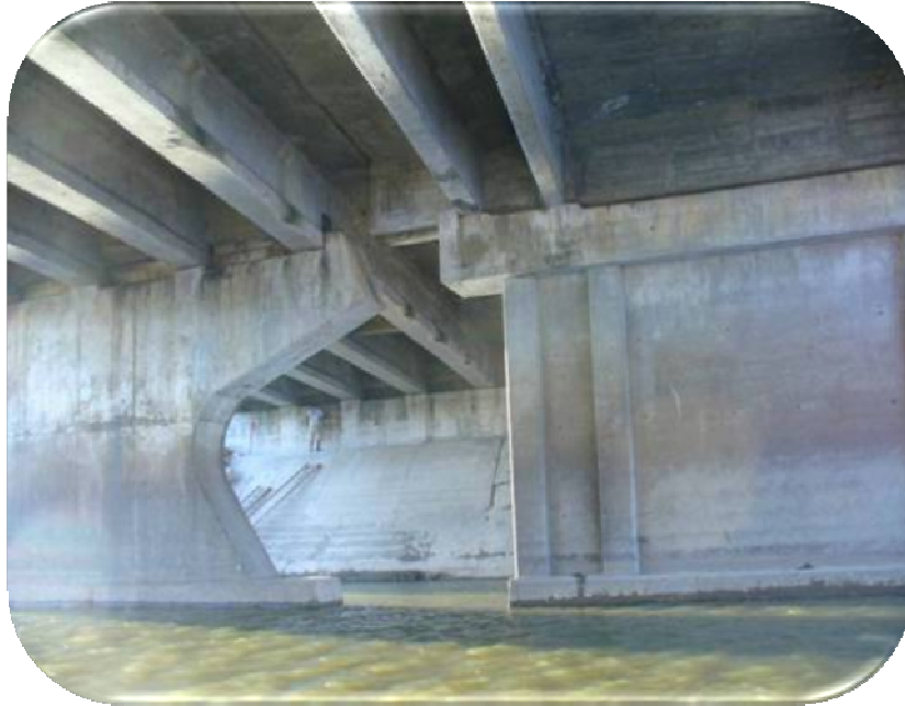
Fig. 57 Vista de las pilas 2 desde pila eje 3, cuerpo "B"
