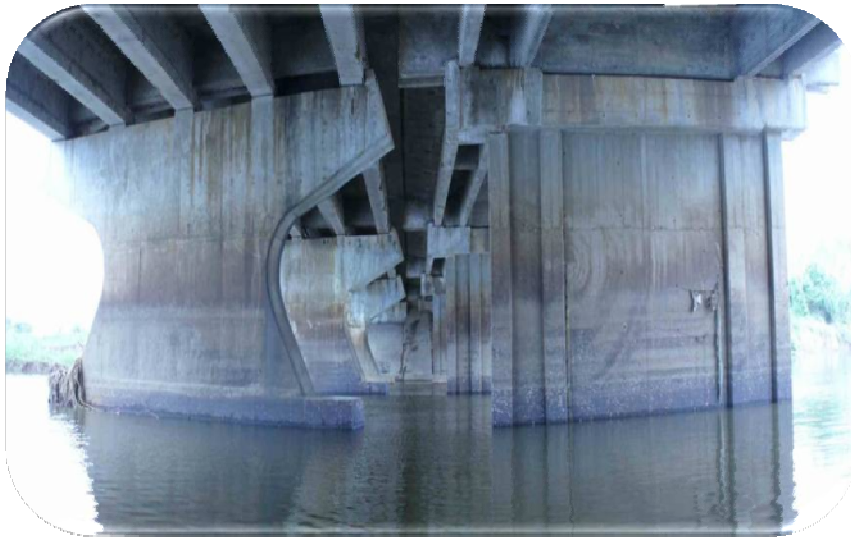
Fig.64 Vista de pila 4 desde pila 3.
