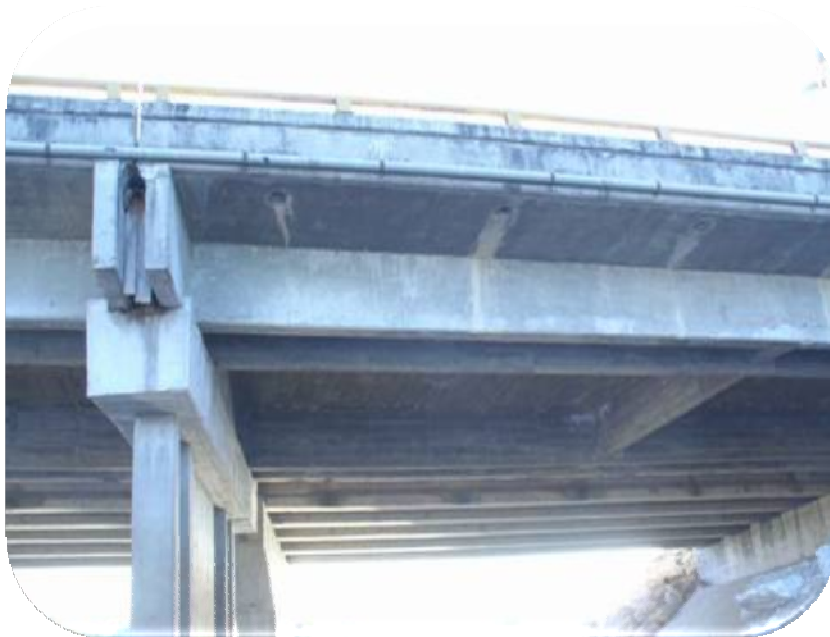
Fig.56 Vista lateral de pila 2 en tramo 1-2, cuerpo "A"
