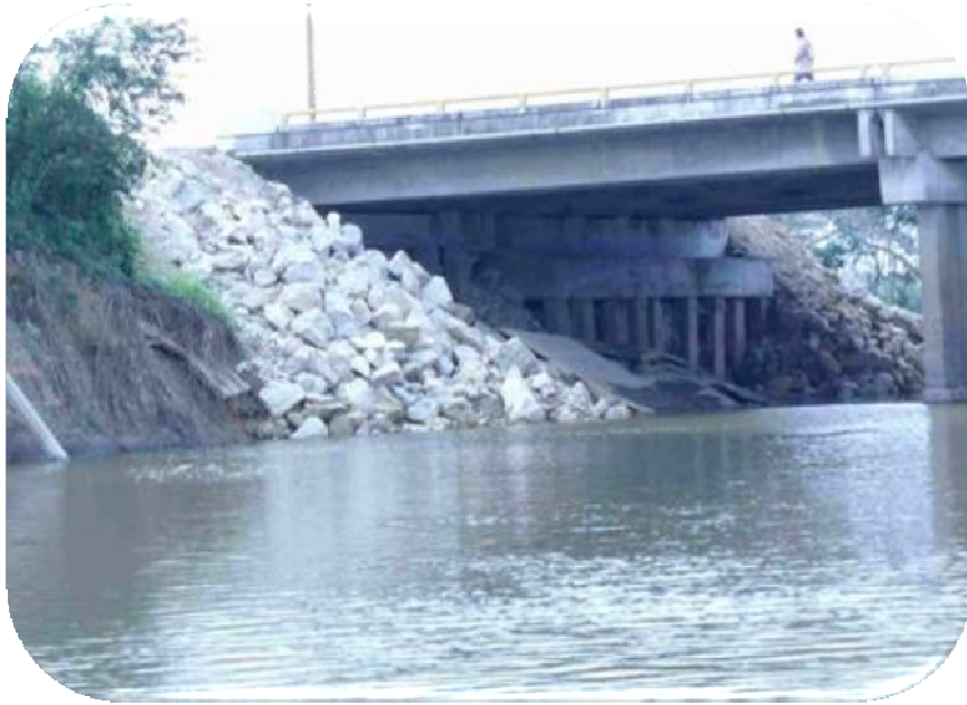
Fig.53 Vista del estribo eje 6
