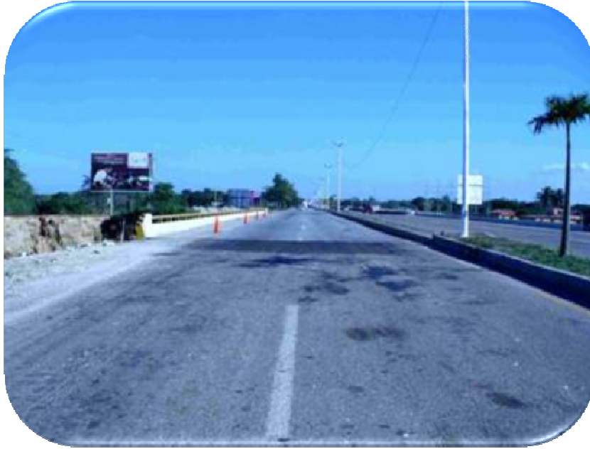
Fig. 55 Vista general del puente aguas abajo
