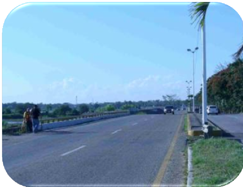
Fig. 54 Vista general del puente aguas arriba
