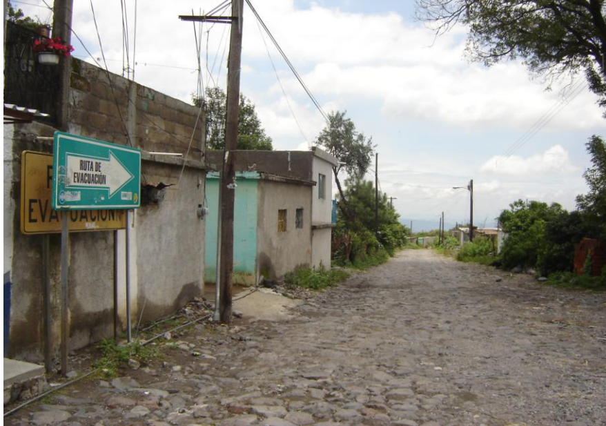
Figura 3.4. Casa con vulnerabilidad moderada.
