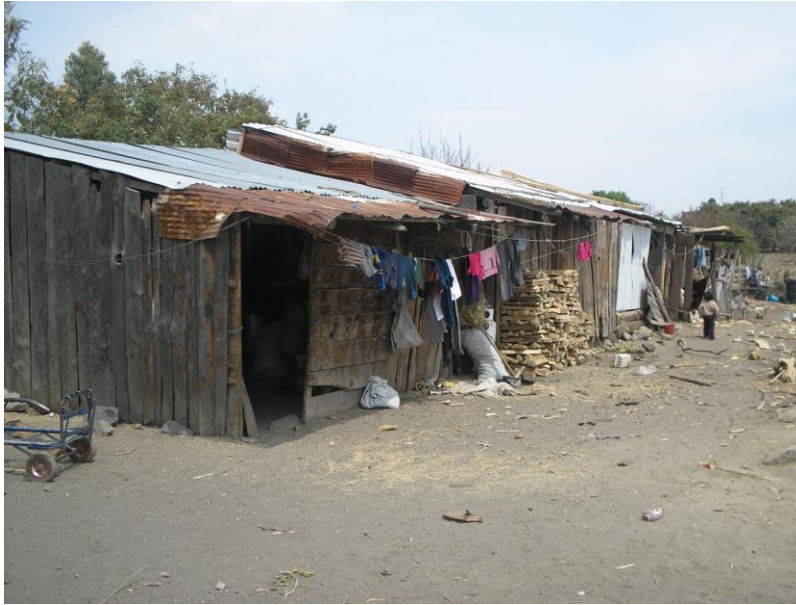
Figura 3.2. Casa con vulnerabilidad muy alta.
