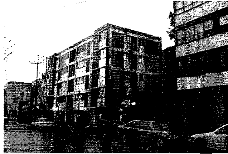
Foto 2: acceso a la Facultad de medicina por metro Copilco, unidades para estudiantes con acabado aparente que no esta integrado al conjunto Universitario.
