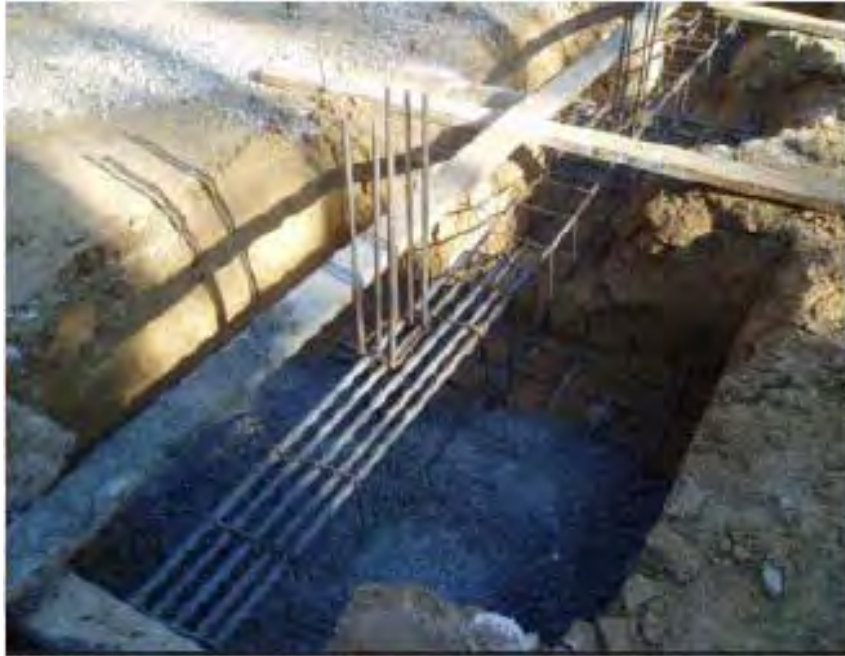
Fig. V.2.3.1.- Cimentación: zanja y zapatas.
