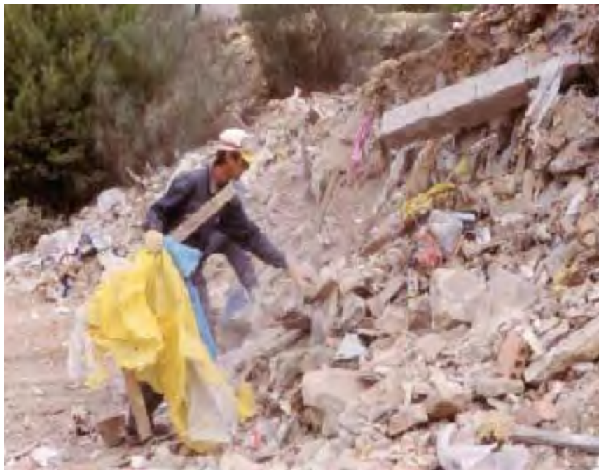
Fig II.2.2.- Foto donde se aprecia la separación elemental de los RCD's.
