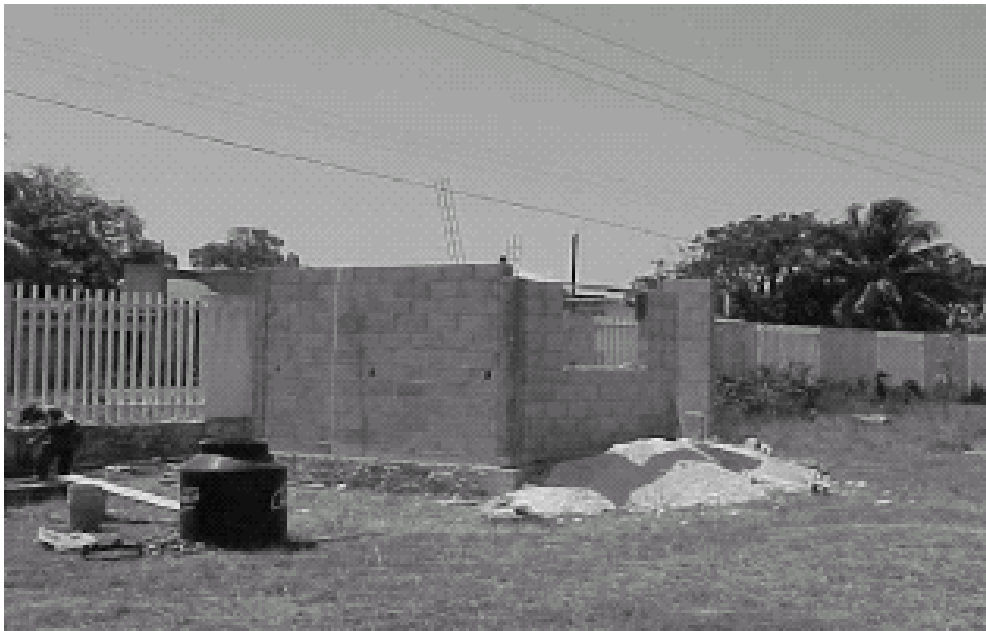
Fig. V.I.6.- Muros, dalas y castillos.
