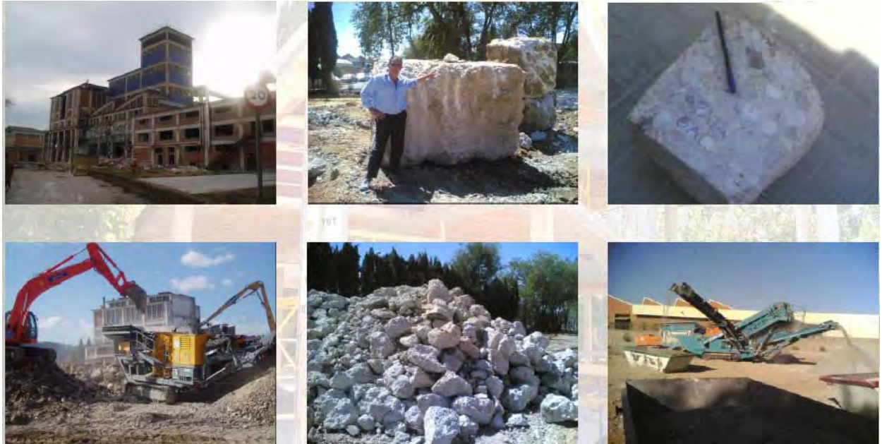
Fig. V.2.1.- Demolición de la fábrica de perfumes GAL.
