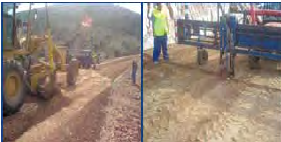
Fig. IV.3.2.1.- Extendido de capa de rodadura con silo móvil SB-2500
