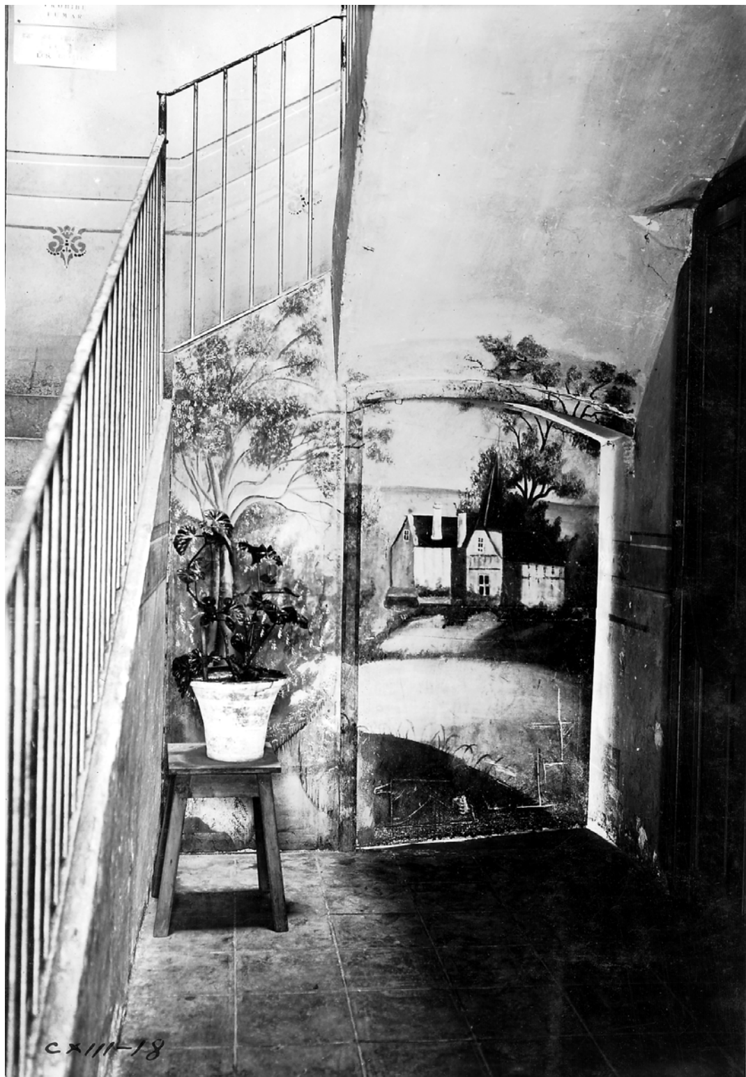
Acceso disimulado al ex convento de Santa Mónica. Las religiosas empleaban esta puerta para introducir los bastimentos al convento. Archivo fotográfico de la Dirección Nacional de Monumentos Históricos del INAH.
