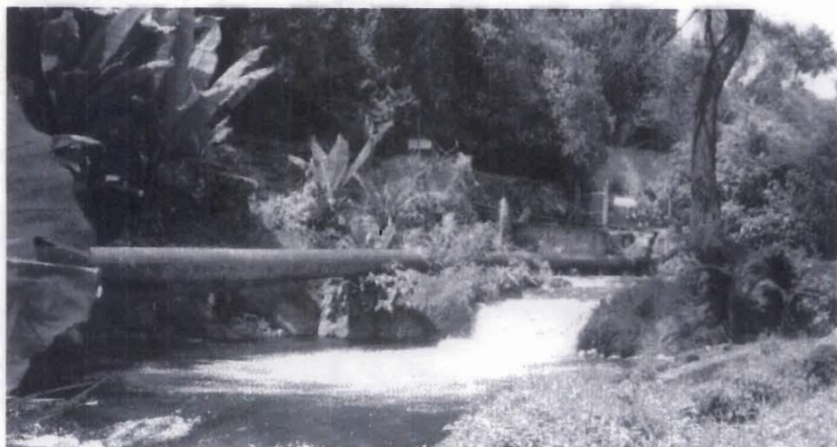
Colector de agua potable Gandarillas II
