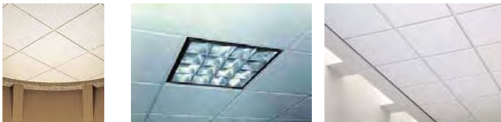
Figura 4.4 Ejemplos de plafón instalado
