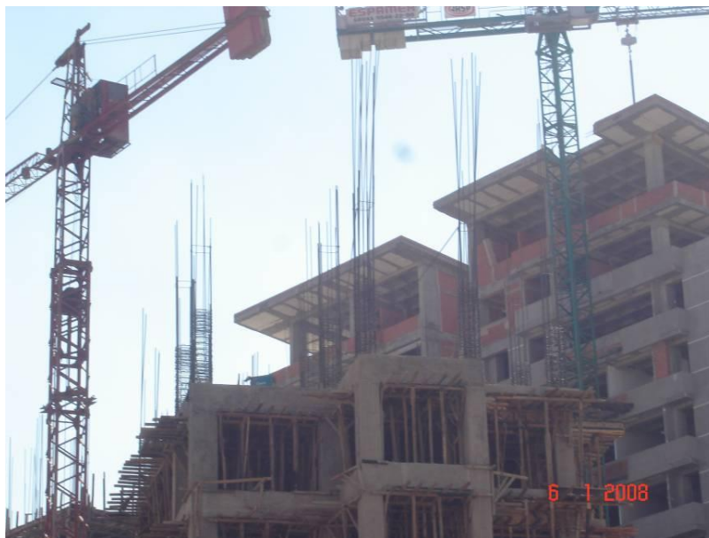
Fotografía 3 Construcción de edificio con base en losa aligerada y muro de block materiales típicos de este tipo de obra
