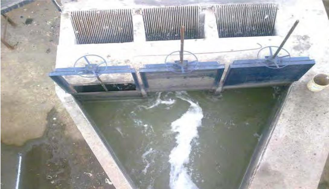
**FIGURA 20.-Foto de las compuertas que dan acceso al agua residual a la planta de tratamiento.**
