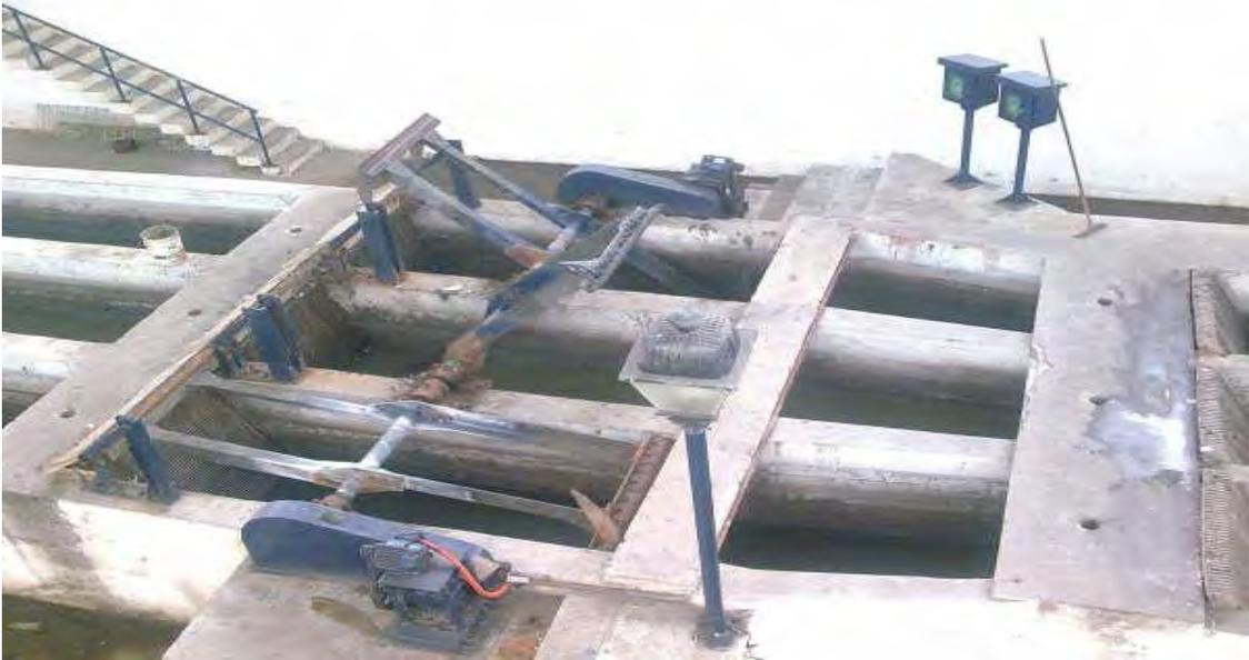
**FIGURA 22.-Foto de las palas mecánicas en operación.**
