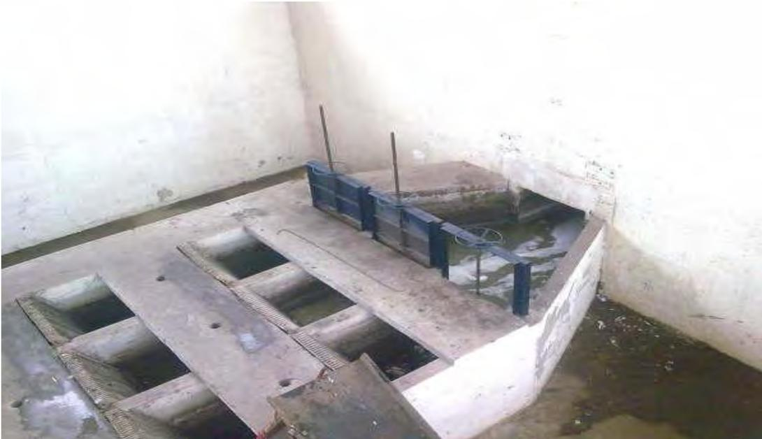
**FIGURA 21.-Foto de las cribas y rejillas en operación.**
