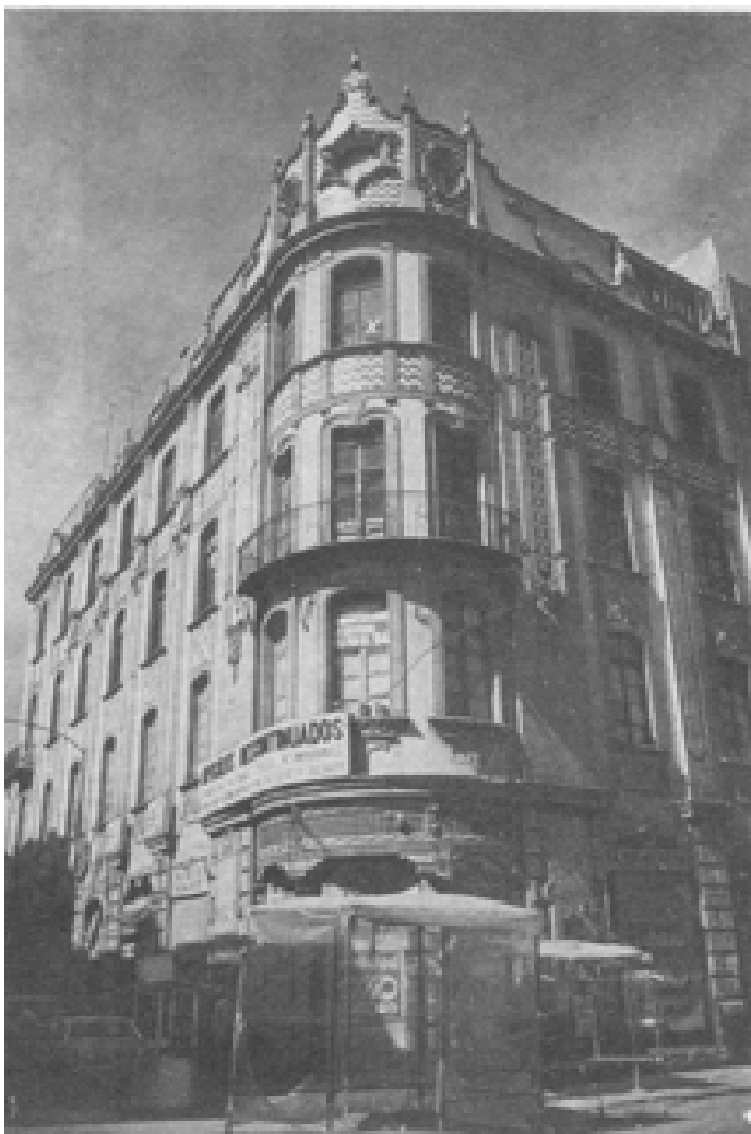
Edificio Sotres y Dosal. Calle Soledad esquina con Jesús María. Federico Mariscal, 1917. Primer edificio neocolonial diseñado de acuerdo a los planteamientos del Ateneo de la Juventud.
