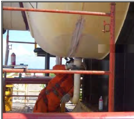
INSPECCIÓN POR LÍQUIDOS PENETRANTES
