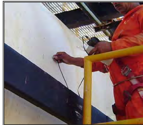
MEDICIÓN DE ESPESORES
