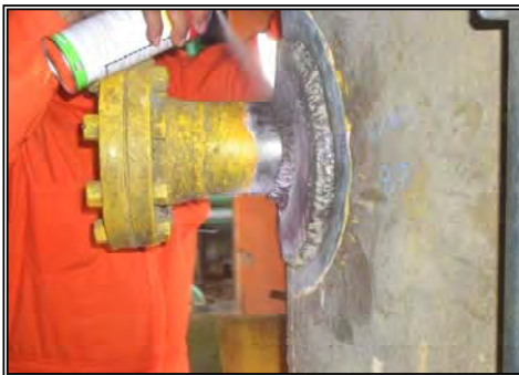
INSPECCIÓN POR LÍQUIDOS PENETRANTES
