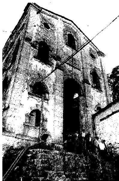
Fachada principal de la casa de máquinas de desagüe de la Mina Dificultad Fuente: colección particular, Quezada Enrique
