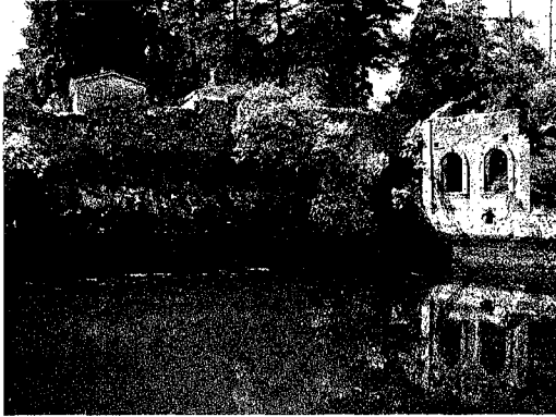
Presa, Mina Dificultad, Real del Monte, Hgo. El almacenaje de agua era necesario para alimentar las calderas y también para el uso general de la mina, pues en la superficie el agua llegaba a escasear irónicamente.
