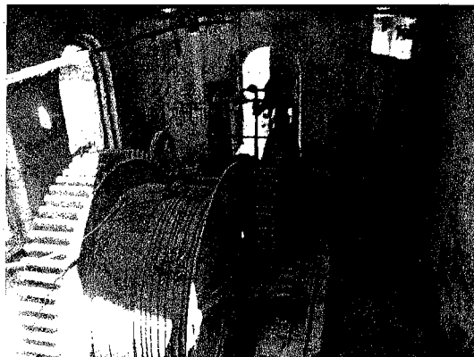
Malacate de vapor de la Mina Dificultad que permanece en el sitio en el que fue instalado originalmente en 1889
