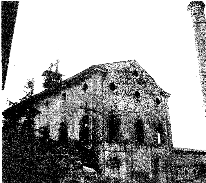
Fachada Posterior de la casa de máquinas y chimenea de la Mina Dificultad, 2008
