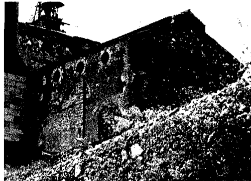
Vista exterior de la antes sala de calderas, hoy bodega
