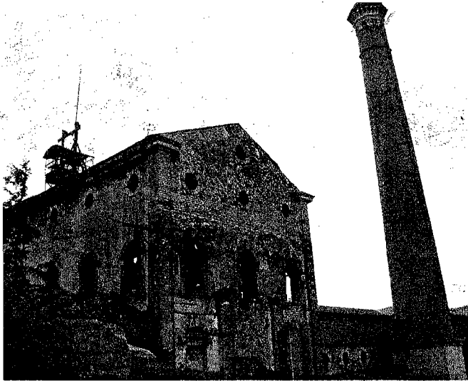
Fachada posterior de la casa de máquina de desagüe de vapor y chimenea de ladrillo de la Mina Dificultad
