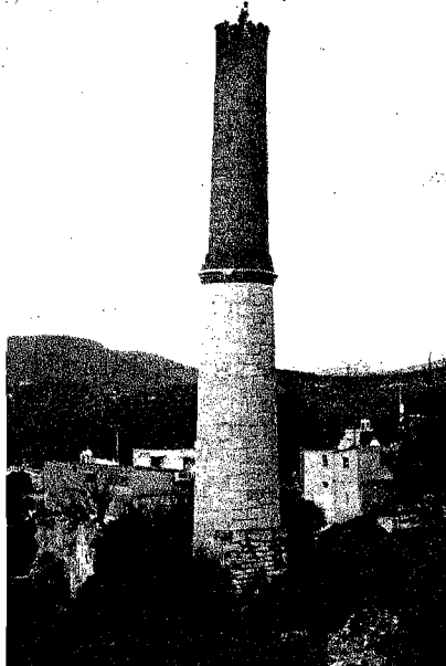
Chimenea de sección redonda del tiro de San Francisco, Pachuca, Hgo.
