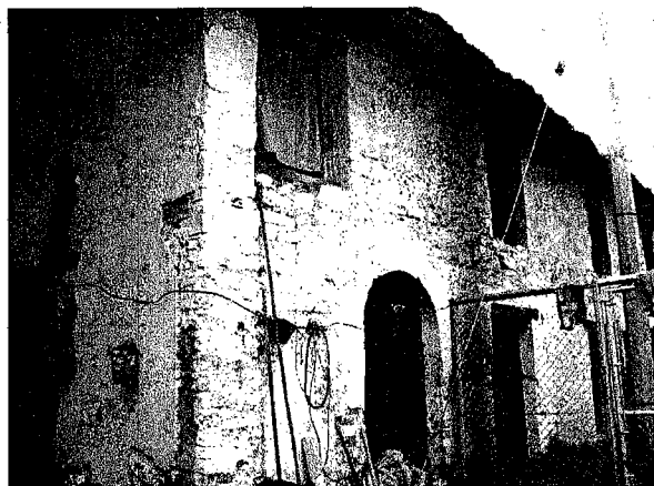
Fachada al interior de la mina de casa habitación
