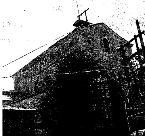
Exterior de Casa de máquina de desagüe.
