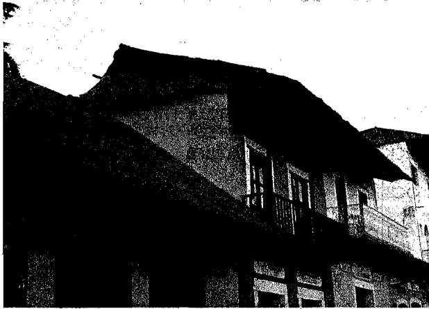
Actualmente se utiliza predominantemente techumbres de lámina galvanizada en los techos de las casas de Real del Monte, en algunas se conservan las tapas de los botes de cianuro que les regalaban en las minas cuando se empezó a beneficiar con el método de cianuración
