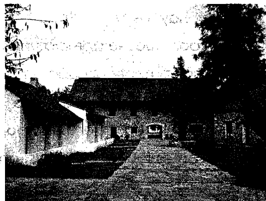
Vista desde el acceso principal
