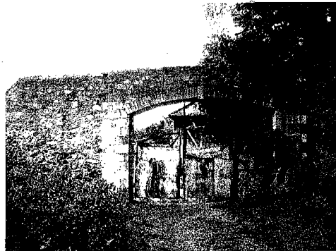
Acceso a la Mina de Cabrera, Comunidad de Guerrero al norte de Real del Monte. Nótese la robustez y altura de los muros que rodeaban las minas. La seguridad era un aspecto que se cuidaba.
