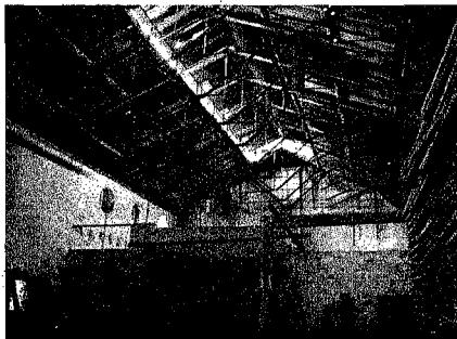
Vista interior de la antes sala de calderas, hoy bodega
