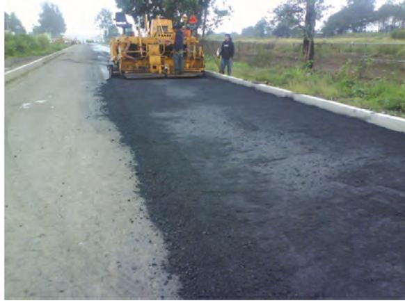
Tendido de Carpeta Asfáltica en Caliente
