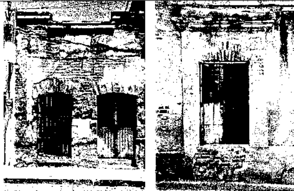
Vivienda Abandonada. Se puede ver el trabajo de forjado de los dinteles. Finca ubicada en calle Melchor Ocampo. LVD 2007
