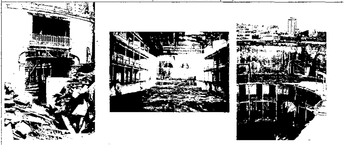
Estado del TAP antes de su reconstrucción 1992 (Archivo Pechesaurio, Fondo Arq. Juan León Loya)
